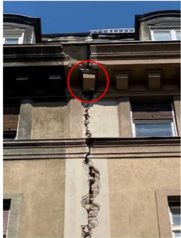
Slika 5.59. - Pogled na oštećeni estetski fasadni element kojeg je hitno potrebno ukloniti radi sveopće sigurnosti ljudi
