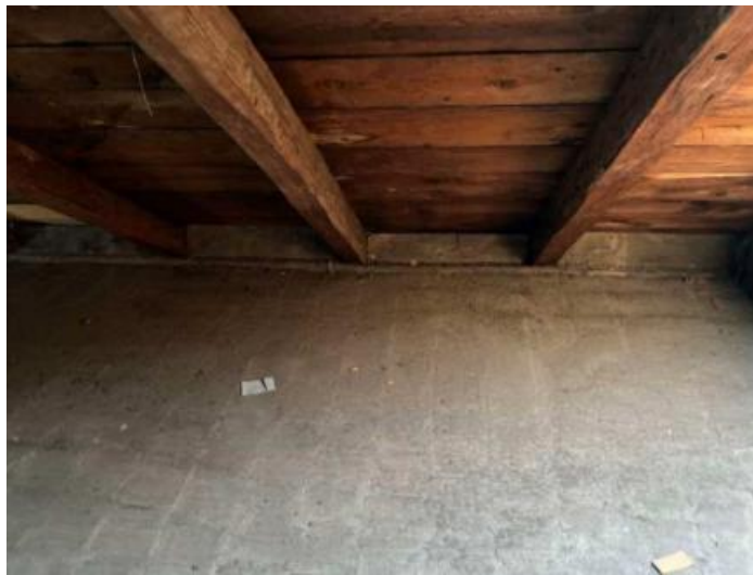
Slika 5.43. - Položaj drvenih grednika poda je u smjeru sjever-jug, isto kao i položaj krovnih elemenata – rogova
