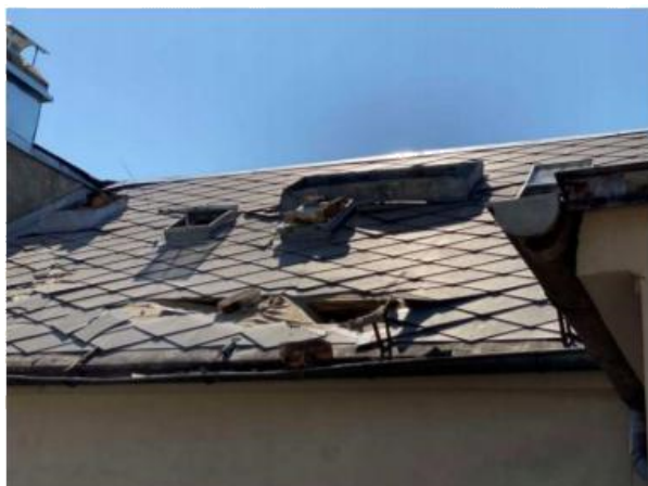
Slika 5.47. - Urušeni dimnjaci na krovu zgrade
