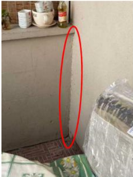
Slika 5.37.- Pukotina na balkonskom parapetu (lijevo); pukotinska oštećenja pregradnog zida (desno)
