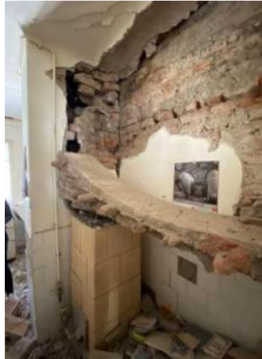
Slika 5.15. - Pogled uzduž krajnjeg istočnog nosivog zida
