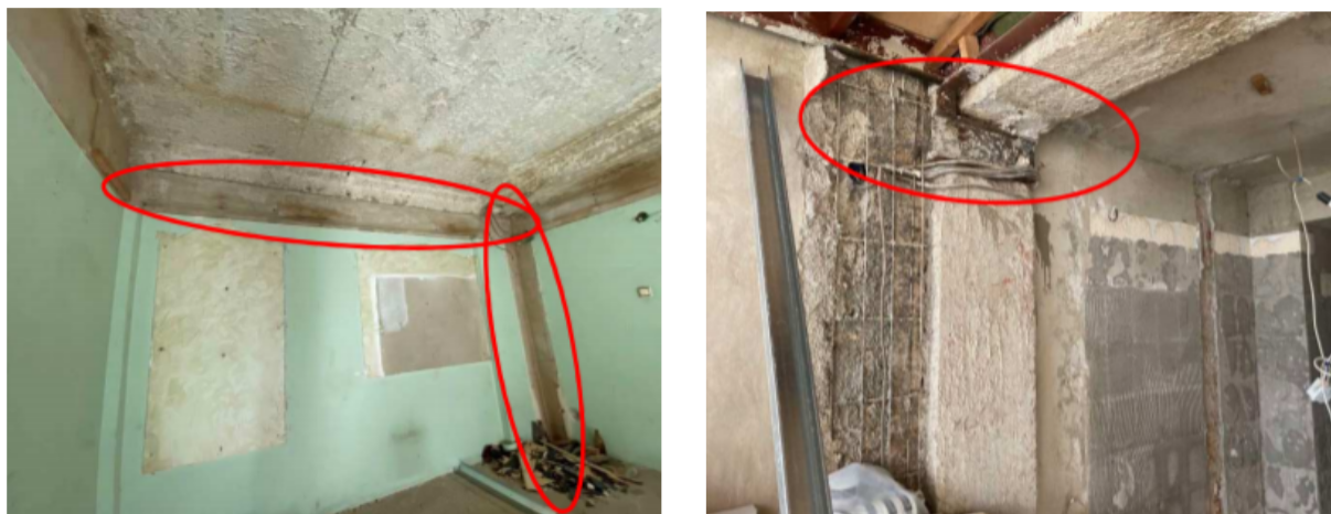
Slika 5.3. - Prizemna prostorija koja dijeli (svoj istočni) zid sa glavnim zidom zgrade
