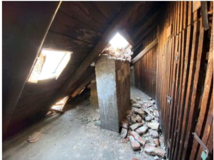
Slika 5.49. - Pogled iz tavanskog prostora na urušene dimnjake
