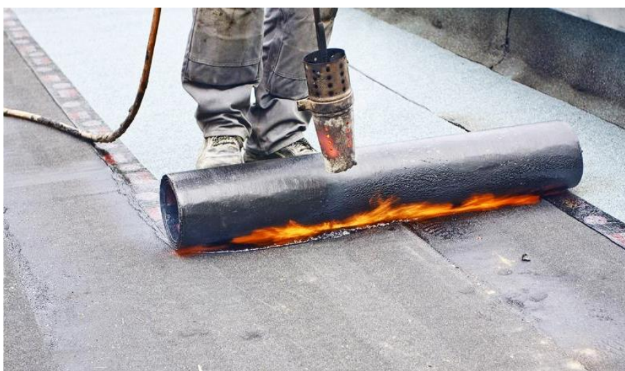
Slika 3. Postupak postavljanja bitumenske HI trake
