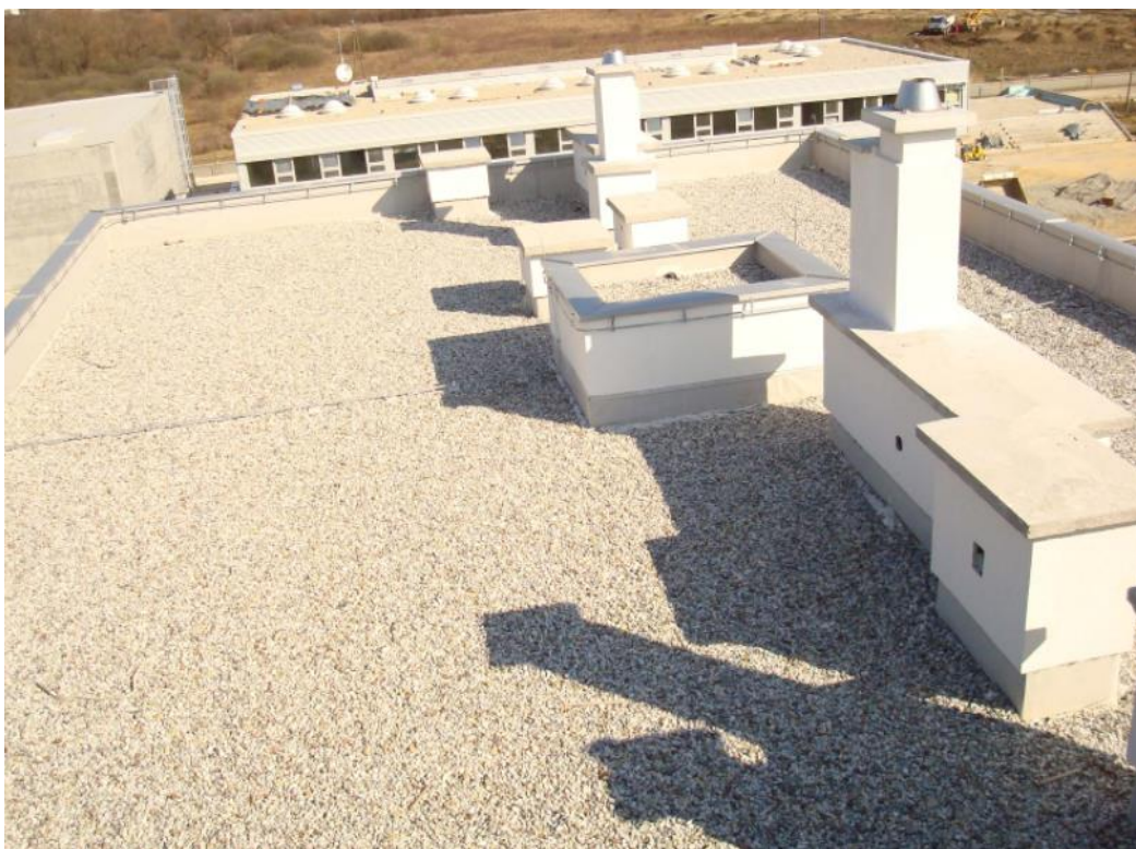
Slika 14. Neprohodni ravni krov sa završnim slojem od šljunka u stambenom naselju
