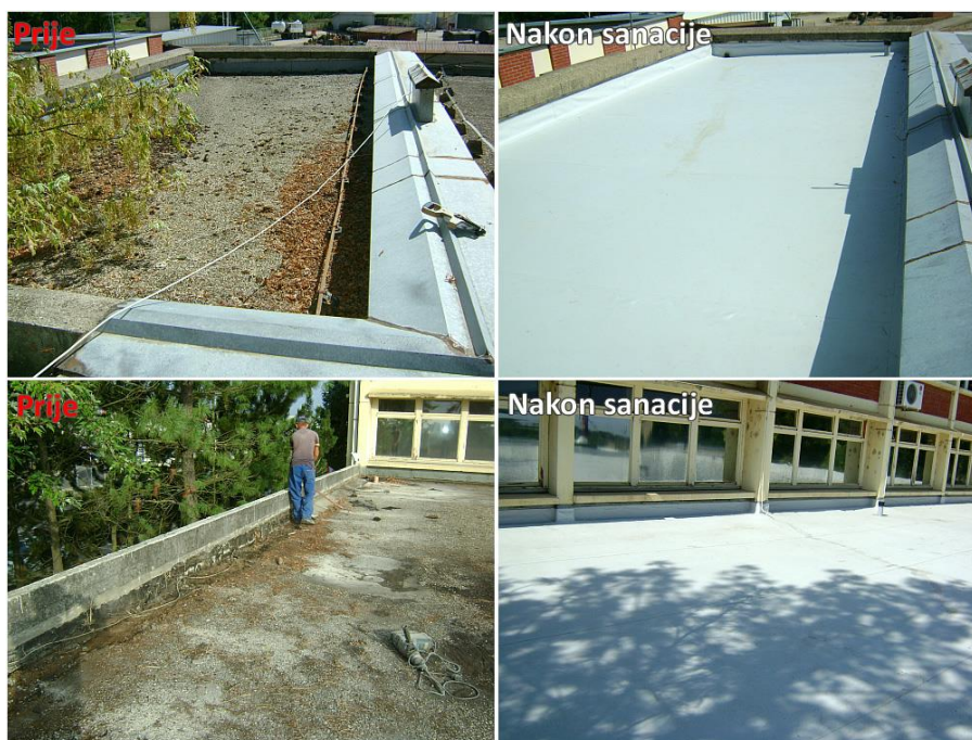
Slika 33. Sanacija ravnog krova restorana u Čakovcu
