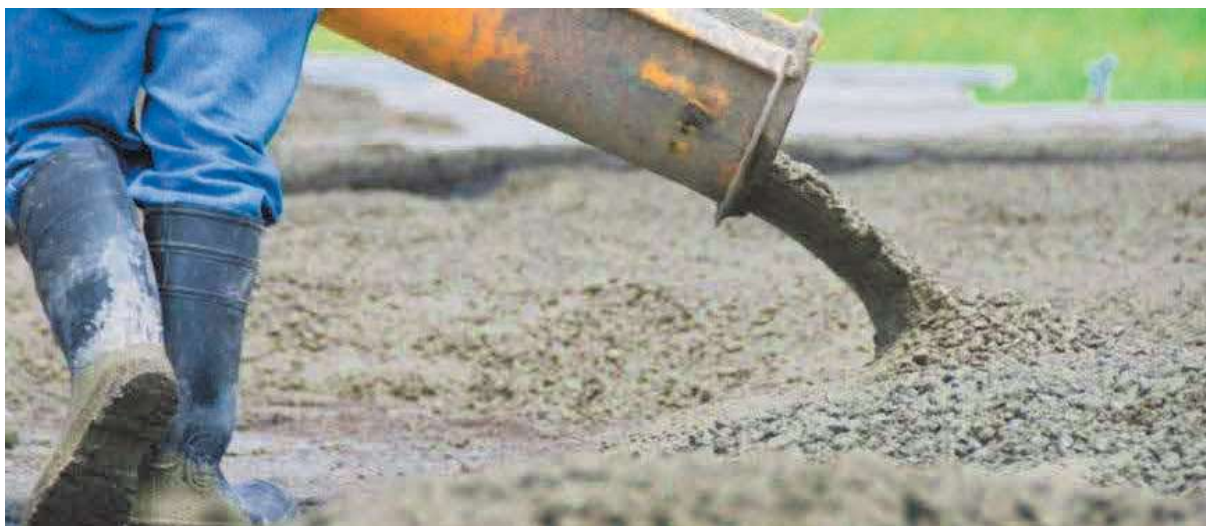
Slika 4 - Betonski radovi, izlivanje betona za betonsku podnu ploču [Izvor: https://www.gtr-mostar.com/betonski-radovi.php ]
