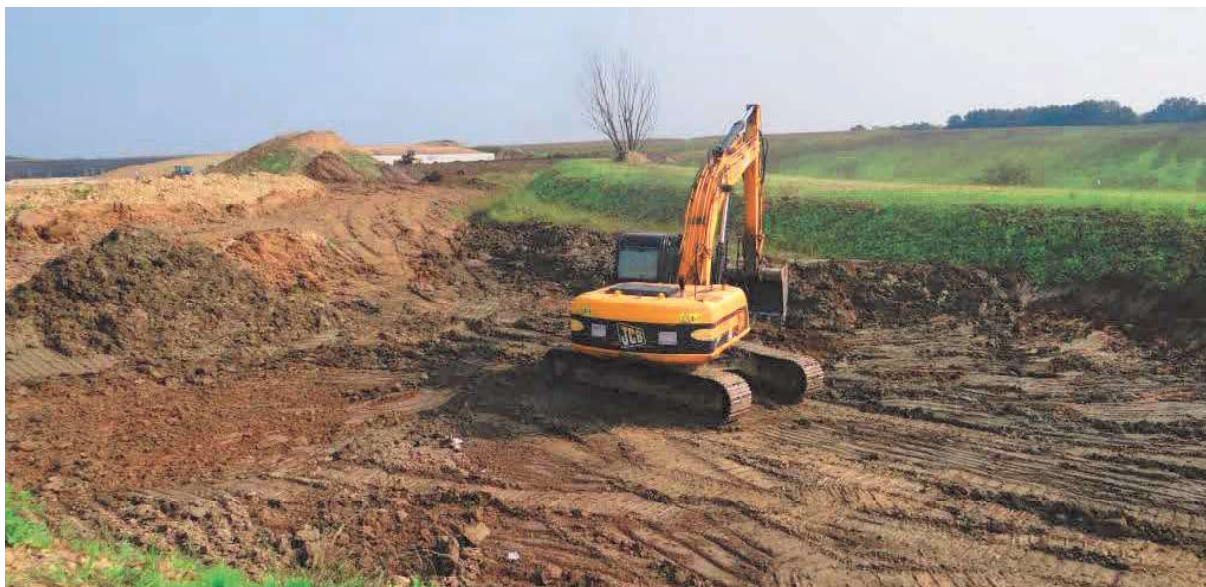
Slika 3 – Zemljani radovi, bager sa jednom lopatom vrši iskop za temelje [Izvor: ambgradnja.hr]
