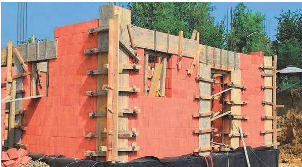
Slika 6 - Tesarski radovi, postavljanje oplata za AB vertikalne serklaže i AB nadvoje [Izvor: https://pravimajstor.hr/stupovi-i-nadvoji ]
