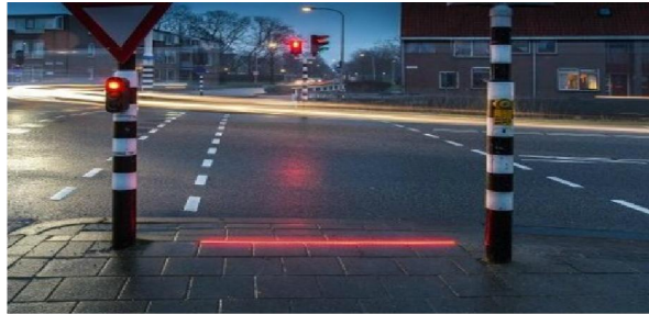
Slika 32. Prometno svjetlo ugrađeno u pločnik
