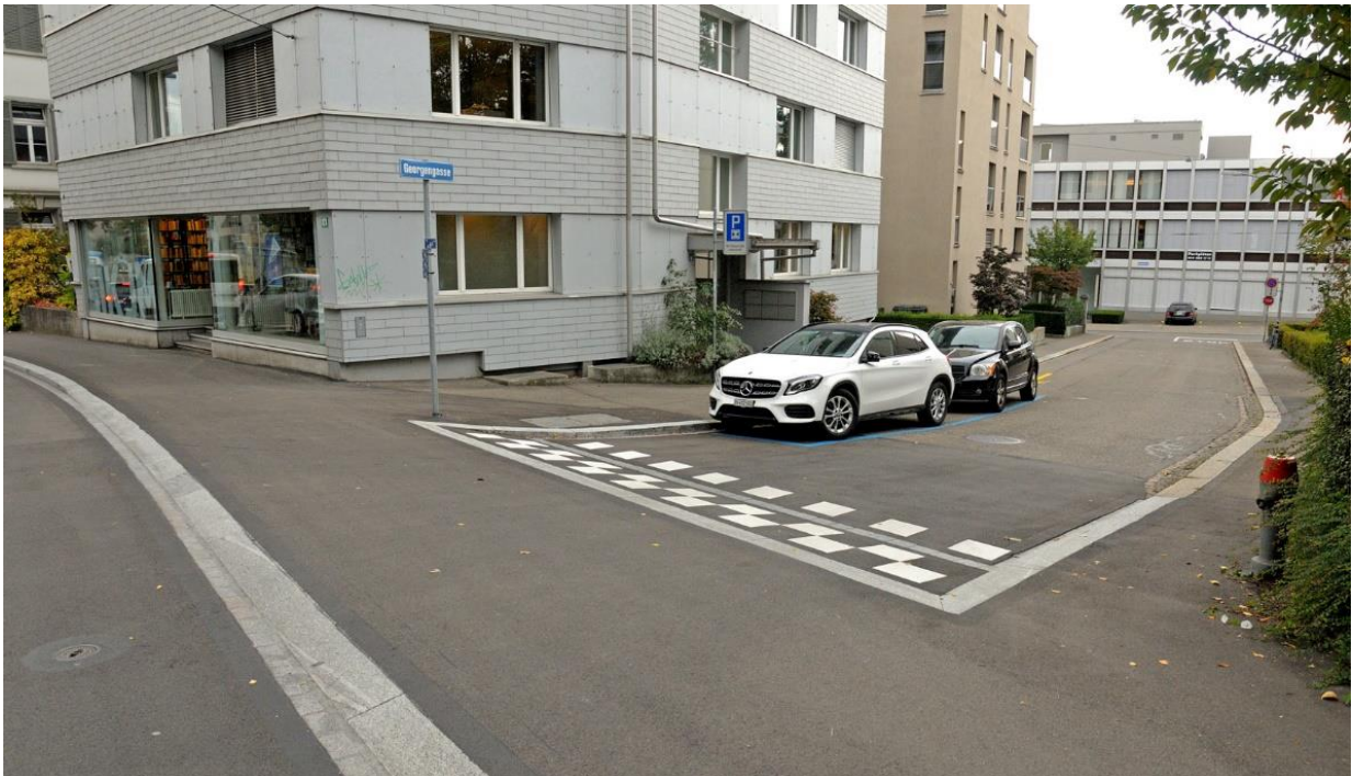
Slika 17. Uzdignuti dijelovi ulice u kojima se iz sporedne ulice prelazi na glavnu ulicu
