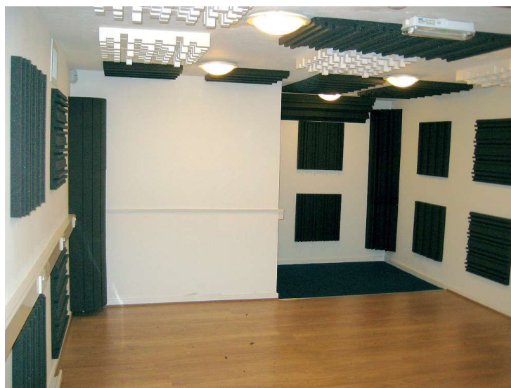
Slika 2.5 14 Akustični tretman sobe s apsorbirajućim panelima, difuzorima i bas zamkama
