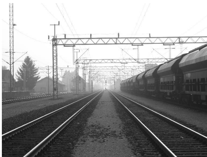
Slika 8.4.1. 37 Autor: Nikola Mišel Puklin, Željeznički kolodvor Koprivnica
