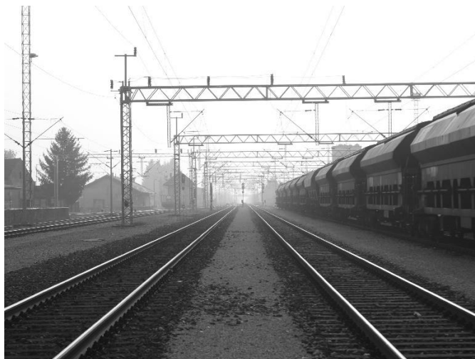
Slika 8.4.1. 37 Autor: Nikola Mišel Puklin, Željeznički kolodvor Koprivnica
