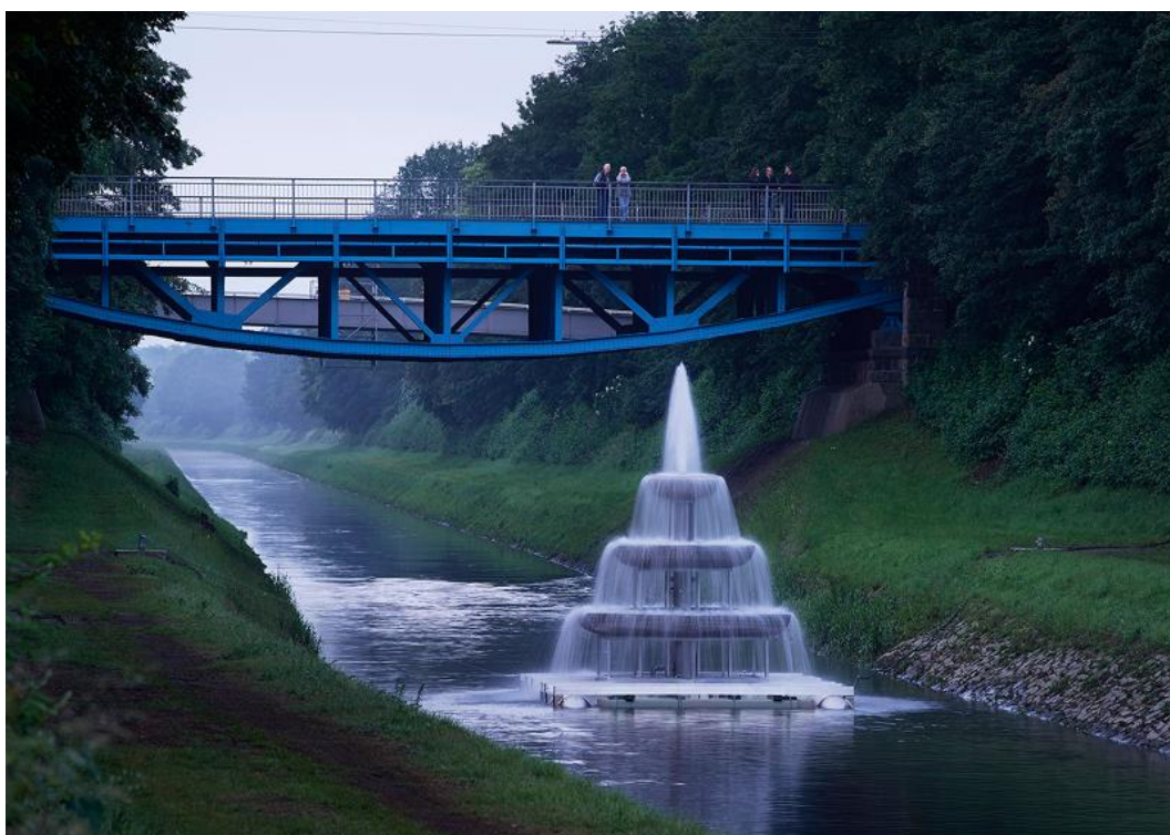
Slika 5.20. Površinski aerator kao i dekorativna fontana (Izvor: http://www.k-w-y.org/filter/Luise/Waste-Water-Fountain )
