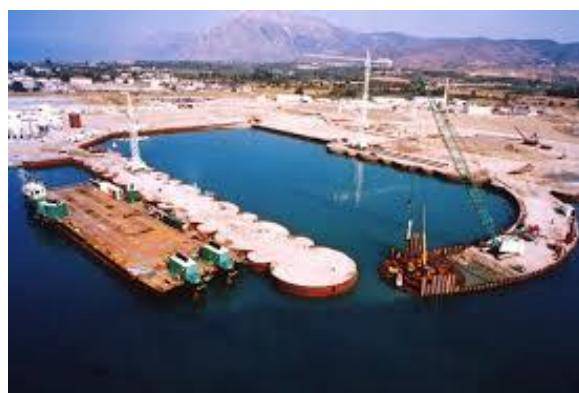
Slika 2.8: Izvođenje kružnih ćelija koferdam u vodi (Izvor:
