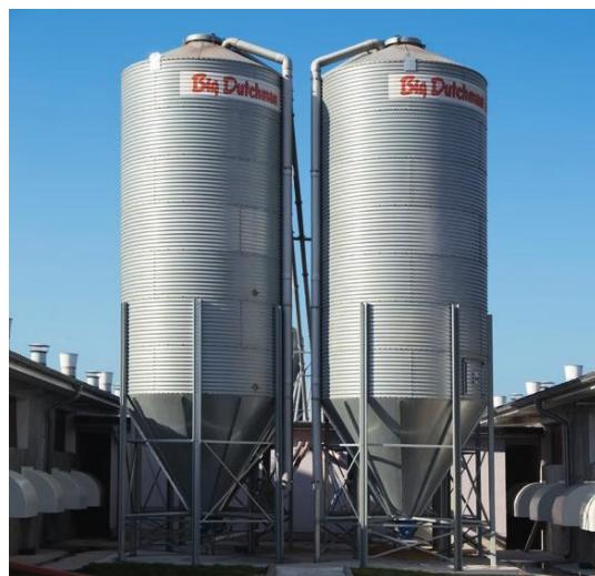
Slika 2.3: Silos od valovitih čeličnih ploča (Izvor: <http://docplayer.com.br/77620988-Silos-spirale-i-puzevi.html>)
