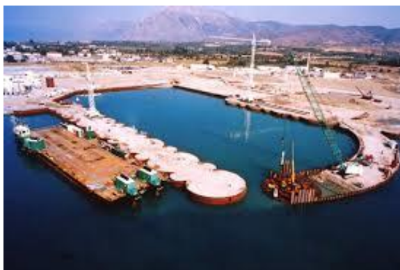
Slika 2.8: Izvođenje kružnih ćelija koferdam u vodi (Izvor:
