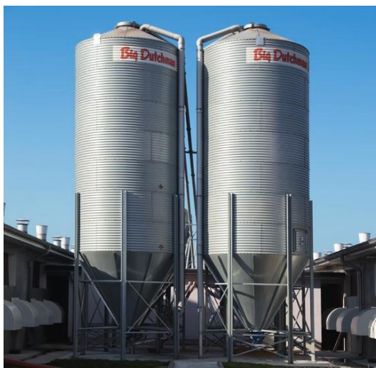
Slika 2.3: Silos od valovitih čeličnih ploča (Izvor: http://docplayer.com.br/77620988-Silos-spirale-i-puzevi.html )
