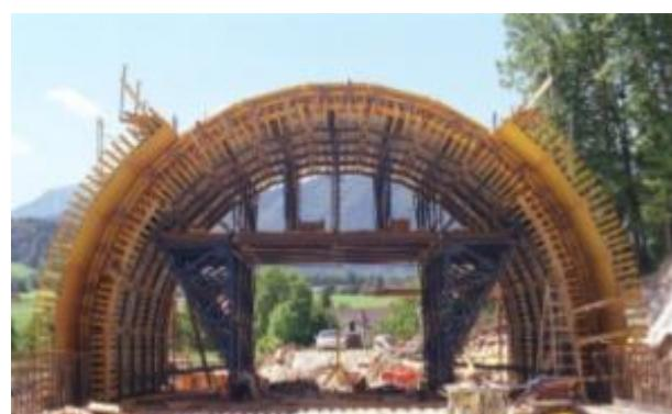
Slika 3.20. Primjena zglobne spojke A Top50
