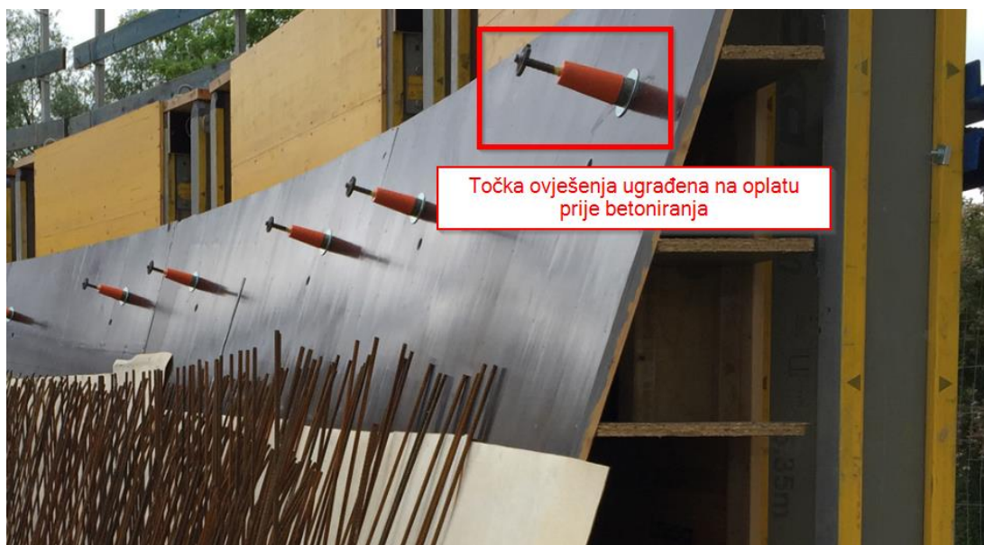
Slika 2.12. Penjajuća oplata i točka ovješnja
