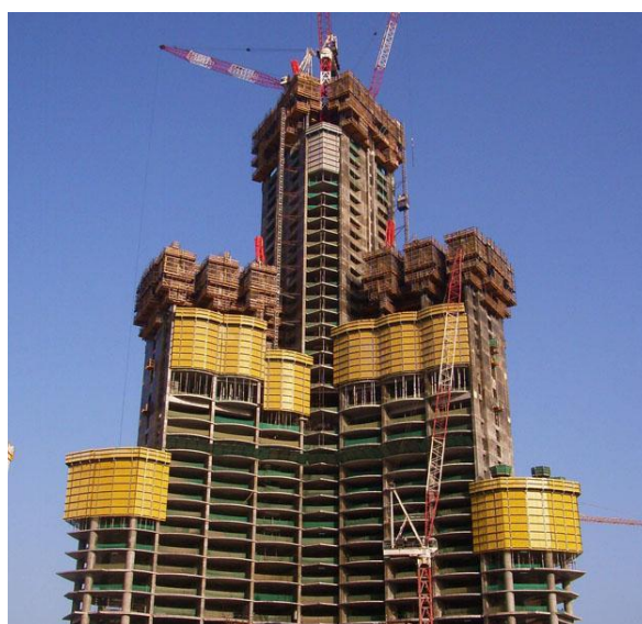
Slika 2.14. Penjajuća oplata SKE50 i SKE100
