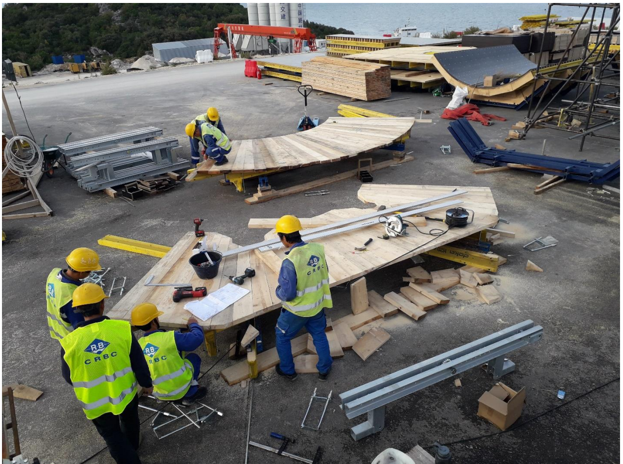
Slika 4.14. Predmontaža penjajućih platformi
