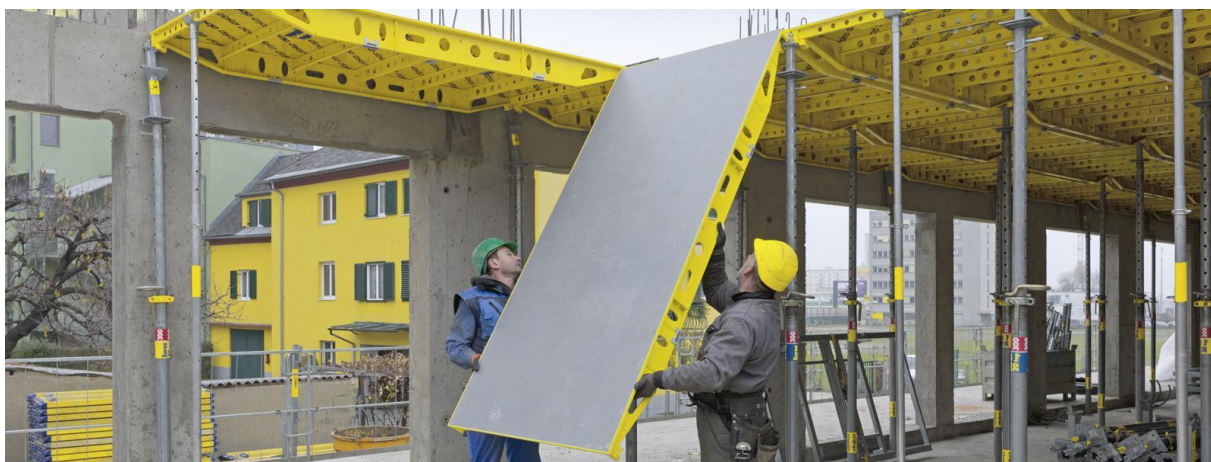
Slika 2.6. Stropna oplata Dokadek 30
