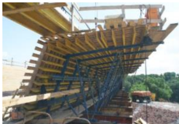
Slika 3.16. Primjer prilagodbe oplata
