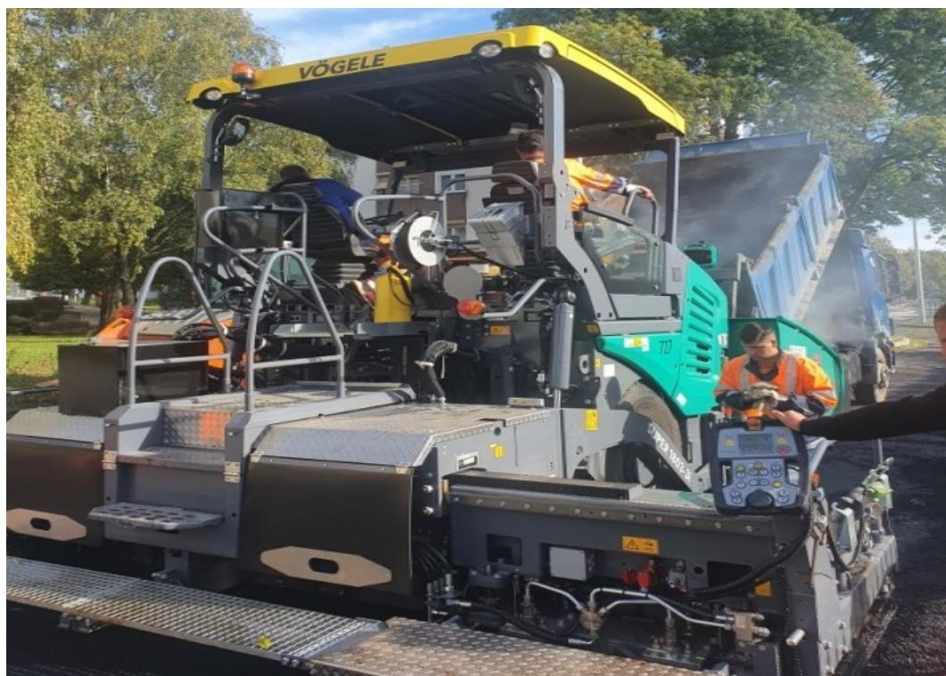
**Slika 4.9 Ugradnja asfaltne mješavine AC 11 surf
