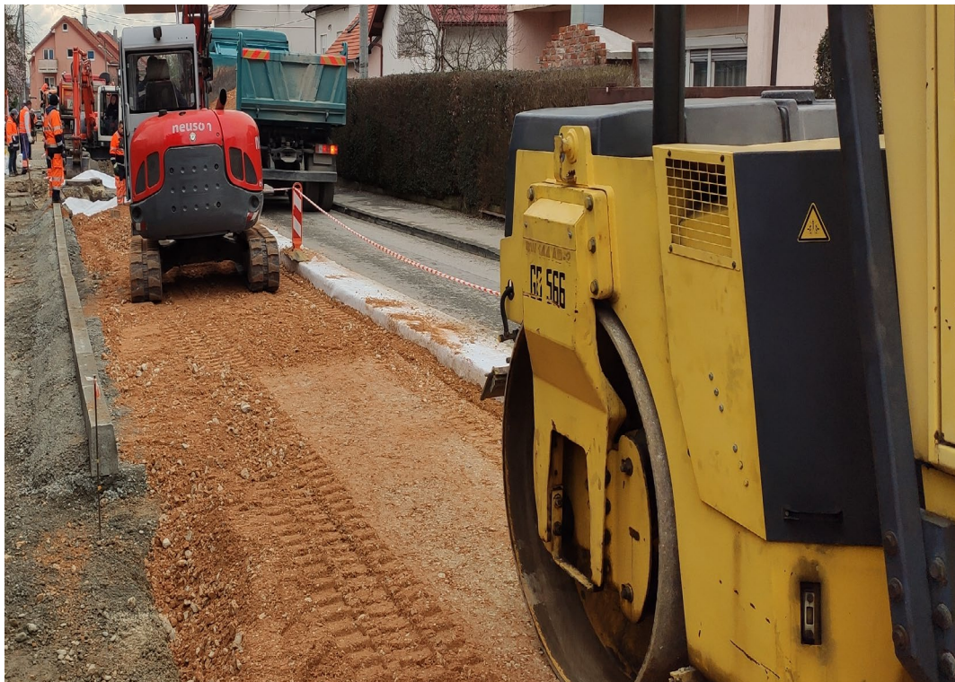
Slika 4.7 Nosivi sloj MNS (vlastiti izvor)
