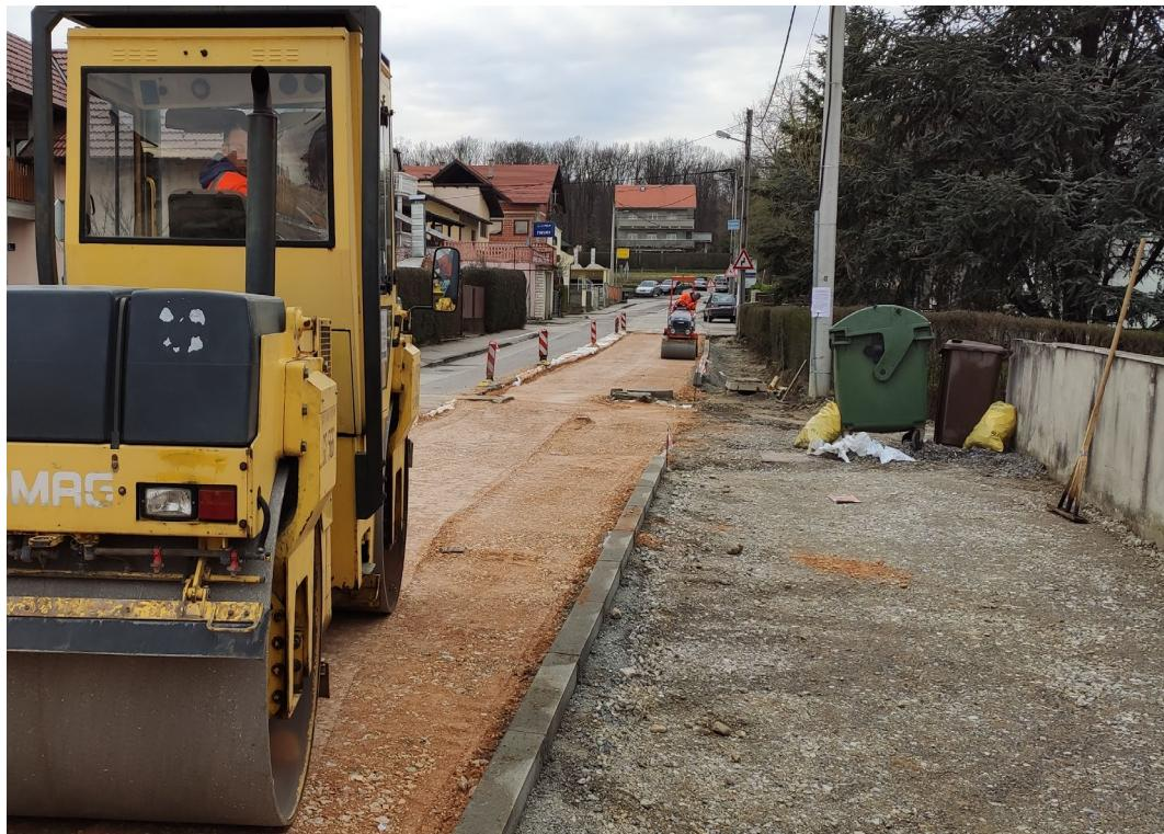
**Slika 4.8 Zbijanje stabiliziranog kamenog materijala valjkom
