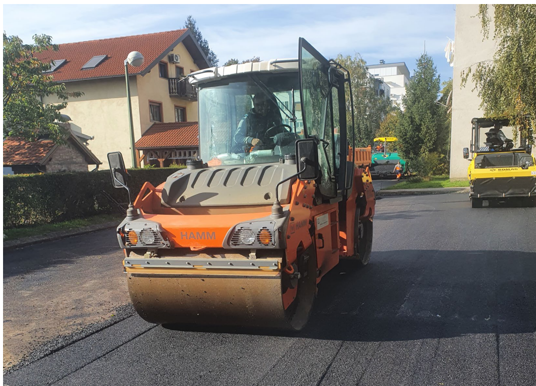
Slika 4.10 Valjanje ugrađene asfaltne mješavine (vlastiti izvor)
