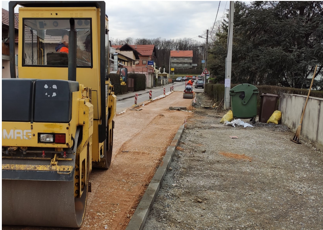
Slika 4.8 Zbijanje stabiliziranog kamenog materijala valjkom (vlastiti izvor)
