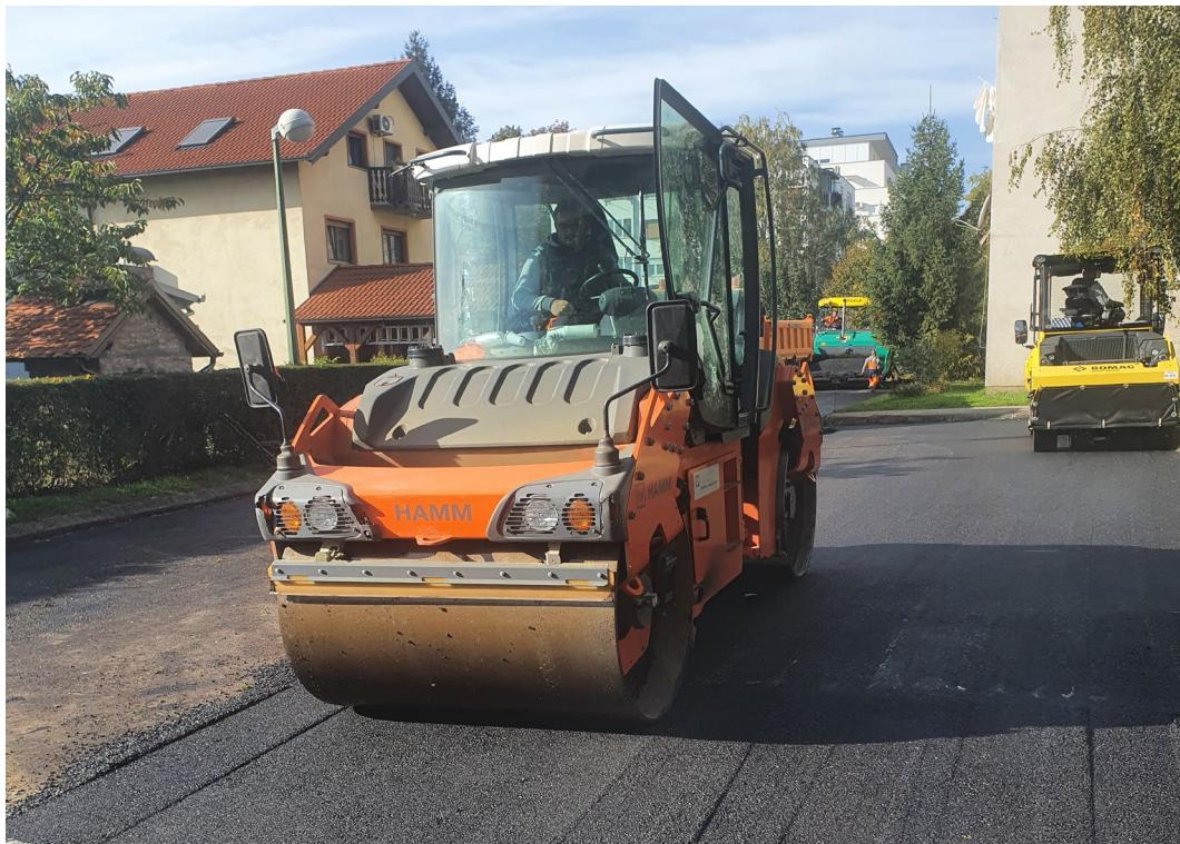
**Slika 4.10 Valjanje ugrađene asfaltne mješavine
