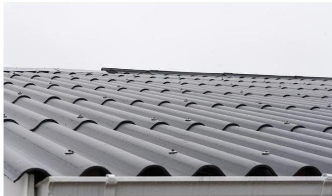
*Slika 5.7 Valovita vlaknasto-cementna ploča*
