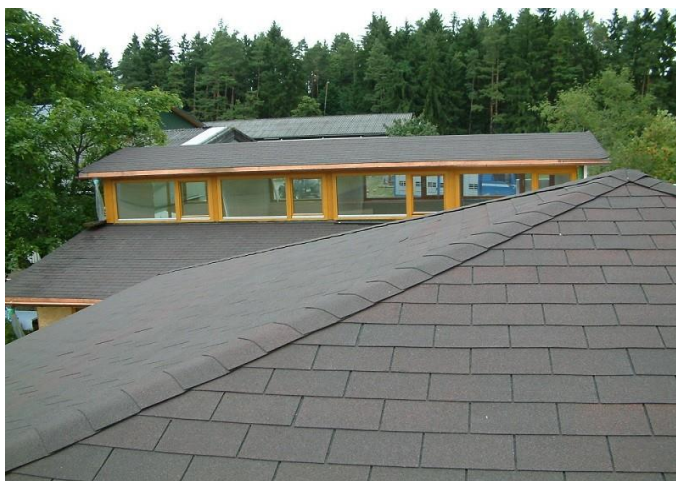
Slika 5.11 Pokrov od bitumenske šindre
