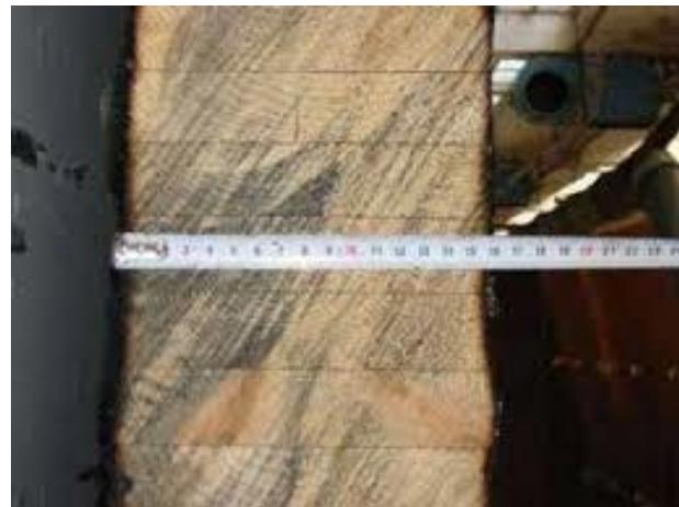
*Slika 7.4 Lamelirani nosač nakon požara*
