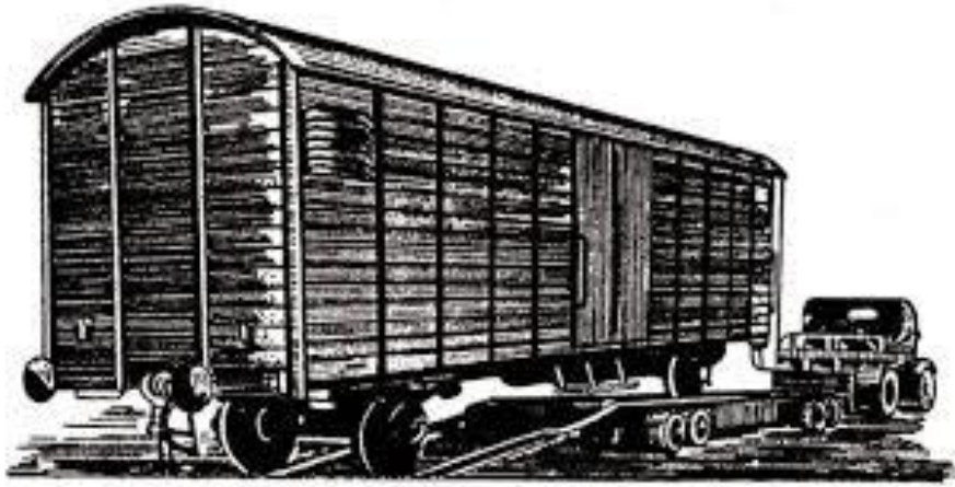
Slika 9. Huckepack A tehnologija - naglavačke
