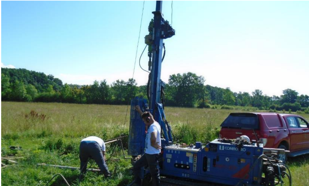
Slika 2.1. Geotehnički istražni radovi na nalazištu
