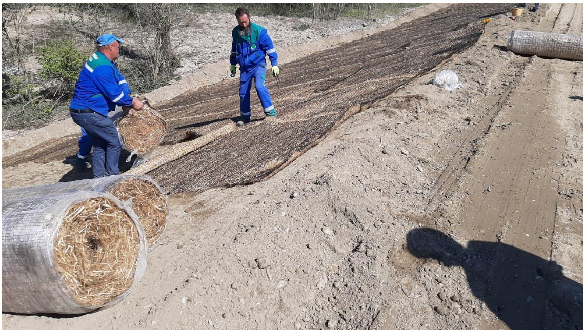
Slika 4.4. Ugradnja geokompozita – VMax SC250 - ojačanje pokosa nasipa
