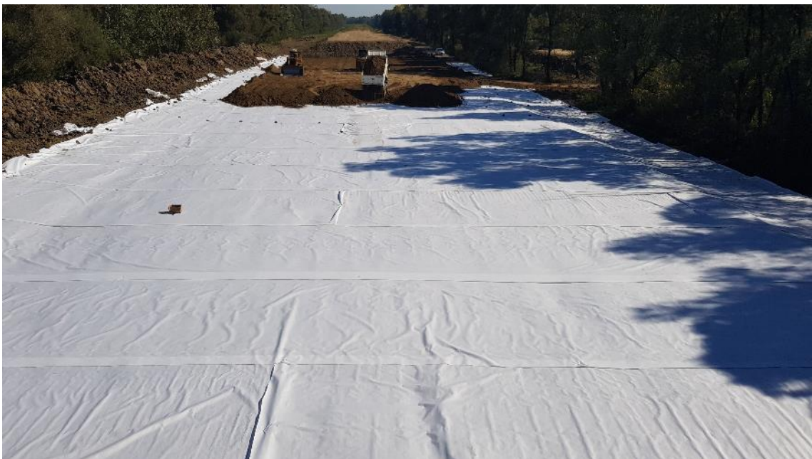
Slika 4.2. Ugradnja geosintetika – geotekstil GEO PP HP 300 – razdjelno / nosivi sloj
