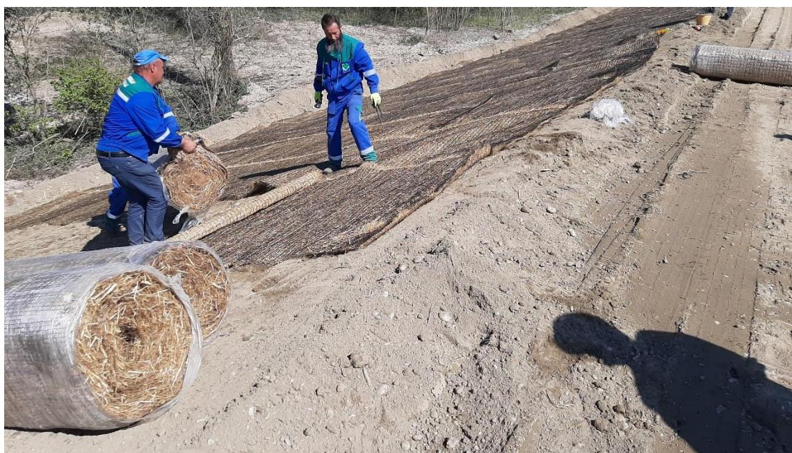
*Slika 4.4. Ugradnja geokompozita – VMax SC250 - ojačanje pokosa nasipa*
