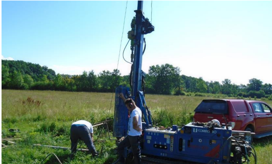
Slika 2.1. Geotehnički istražni radovi na nalazištu
