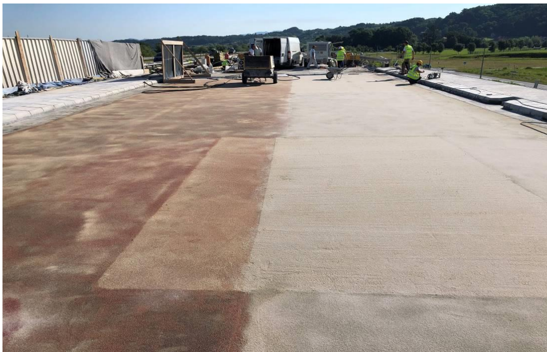
Slika 80. Ugradnja epoksidnog premaza i epoksidnog morta na kolničku ploču nadvožnjaka
