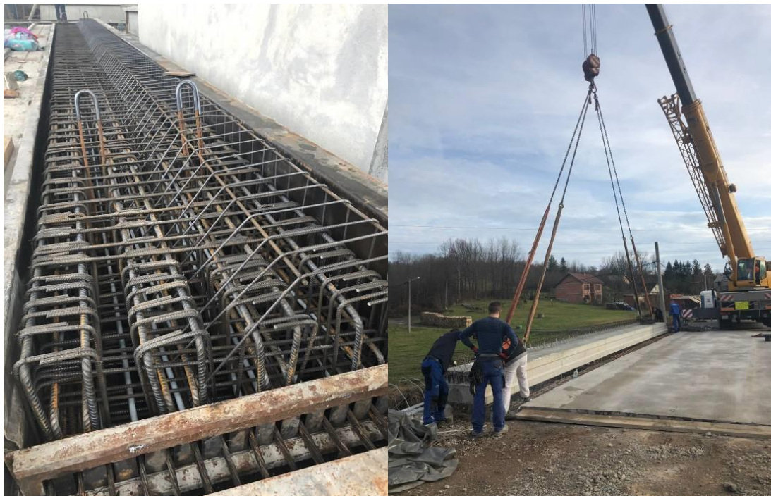
Slika 42. Izrada i montaža adhezijski prednapetog nosača
