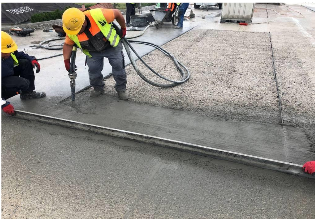
Slika 27. Reprofilacija kolničke ploče nadvožnjaka Zabok reparaturnim mortom
