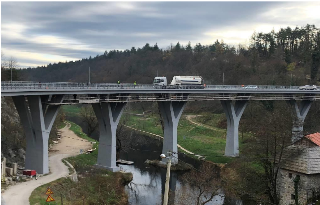
Slika 52. Demontaža skele i izgled konstrukcije nakon završenih radova
