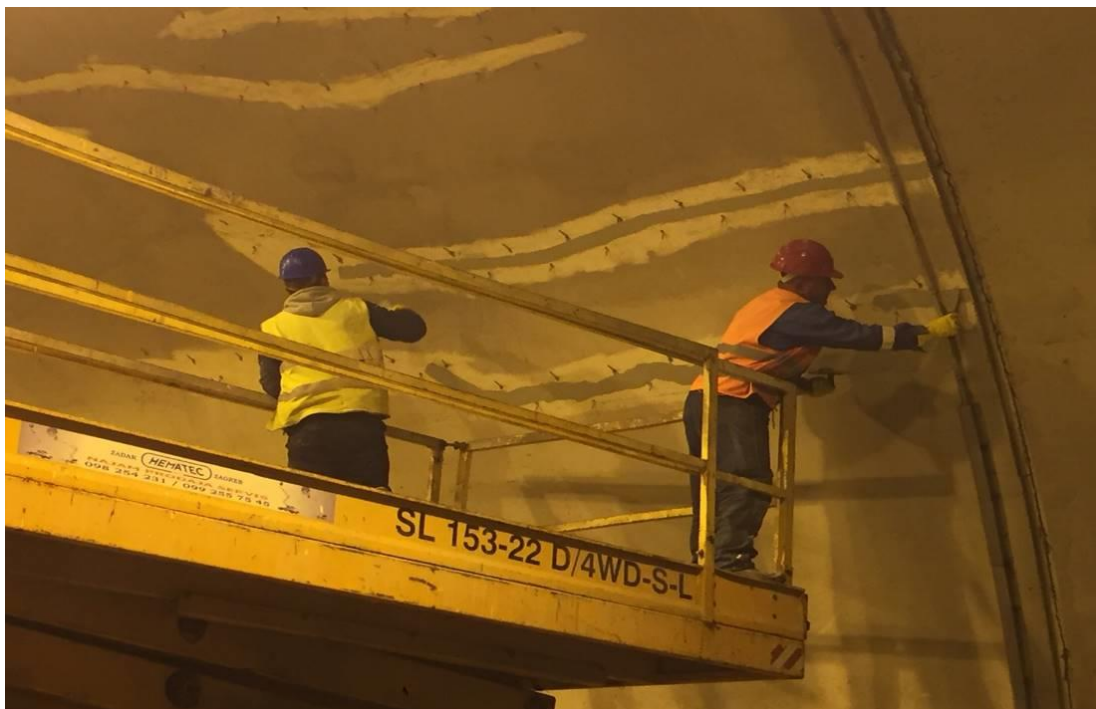
Slika 57. Postavljanje pakera i brtvljenje traga pukotine
