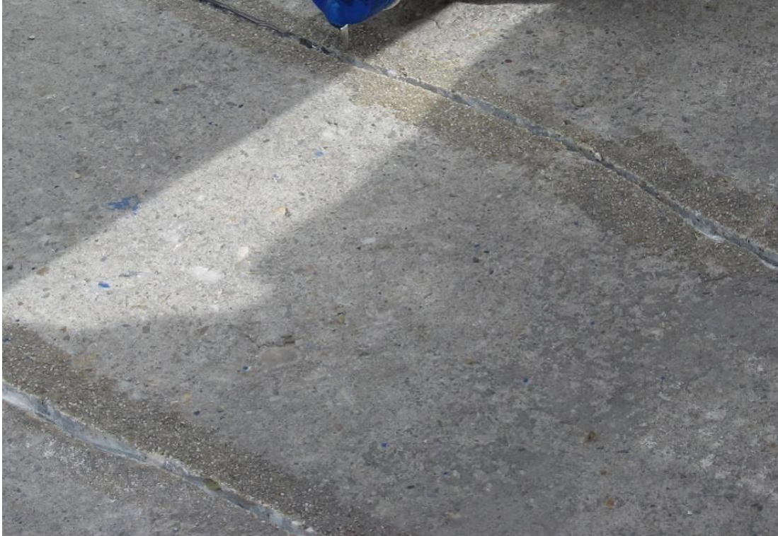
Slika 33. Gravitacijsko injektiranje
