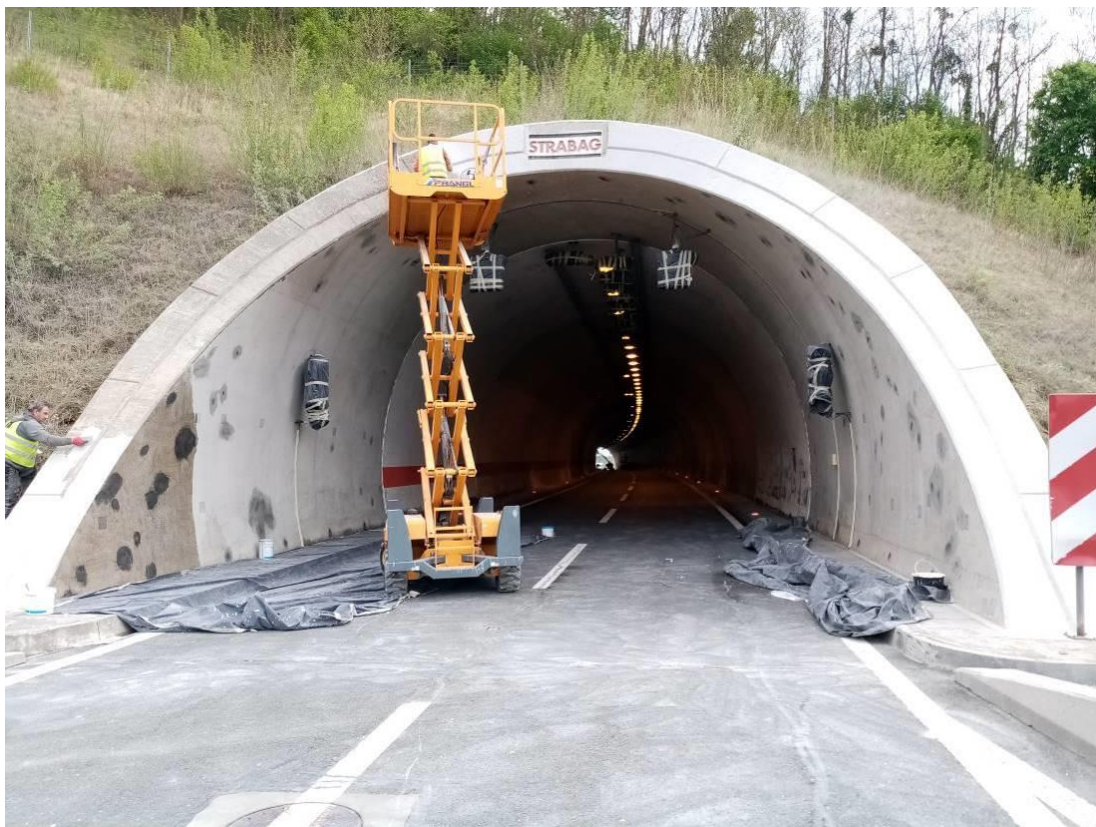
Slika 58. Sanacija lokalnih oštećenja i nanošenje primera
