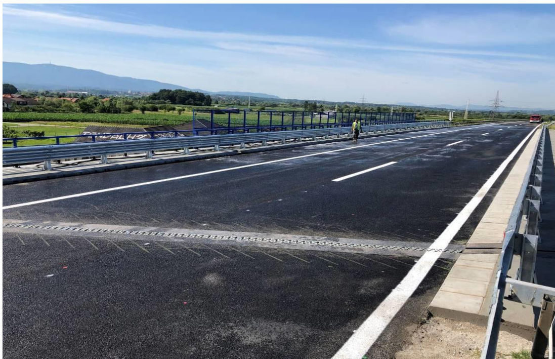
Slika 84. Izgled nadvožnjaka nakon završenih sanacijskih radova
