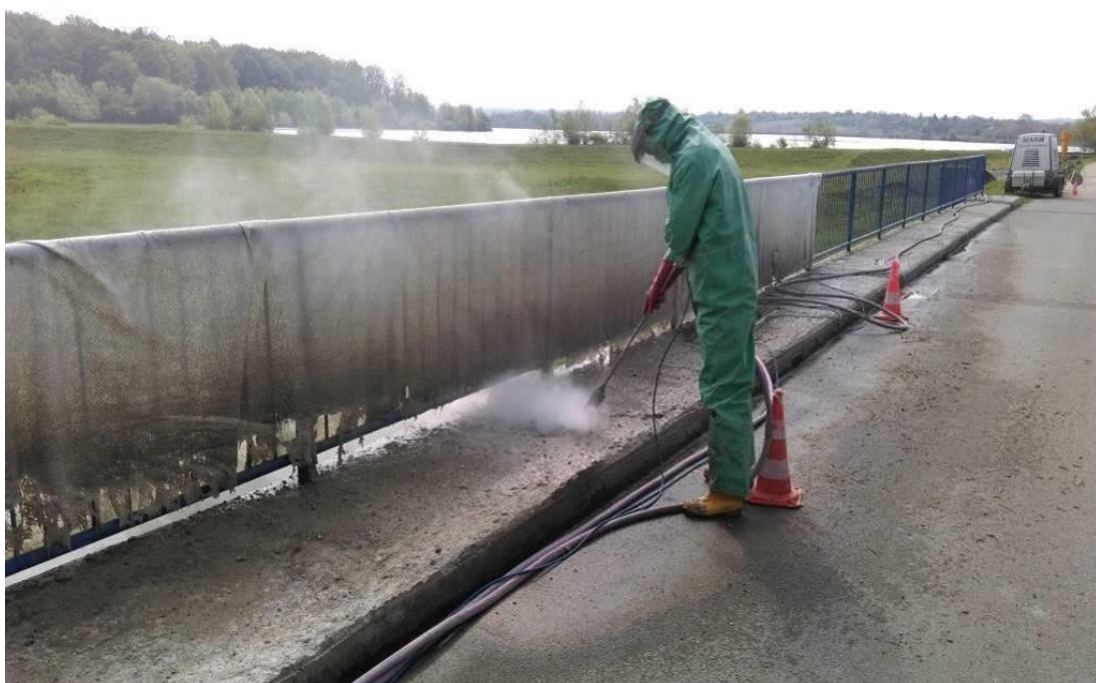
Slika 24. Hidrodemoliranje hodnika mosta Siščani
