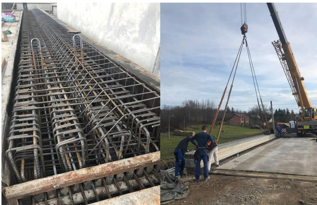
Slika 42. Izrada i montaža adhezijski prednapetog nosača
