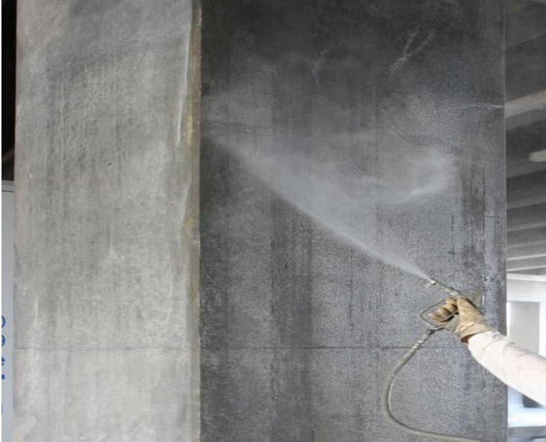
Slika 37. Primjena hidrofobne impregnacije na stupašte nadvožnjaka
