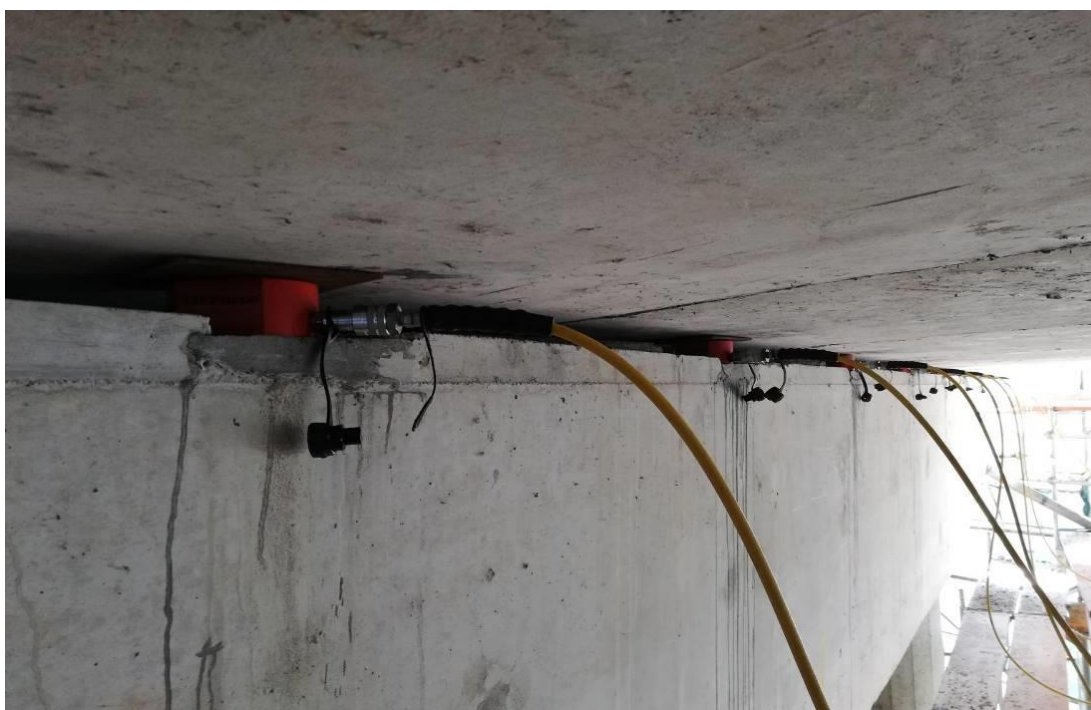
Slika 78. Odizanje konstrukcije mosta hidrauličnim cilindrima u svrhu zamjene dotrajalih neoprenskih ležajeva
