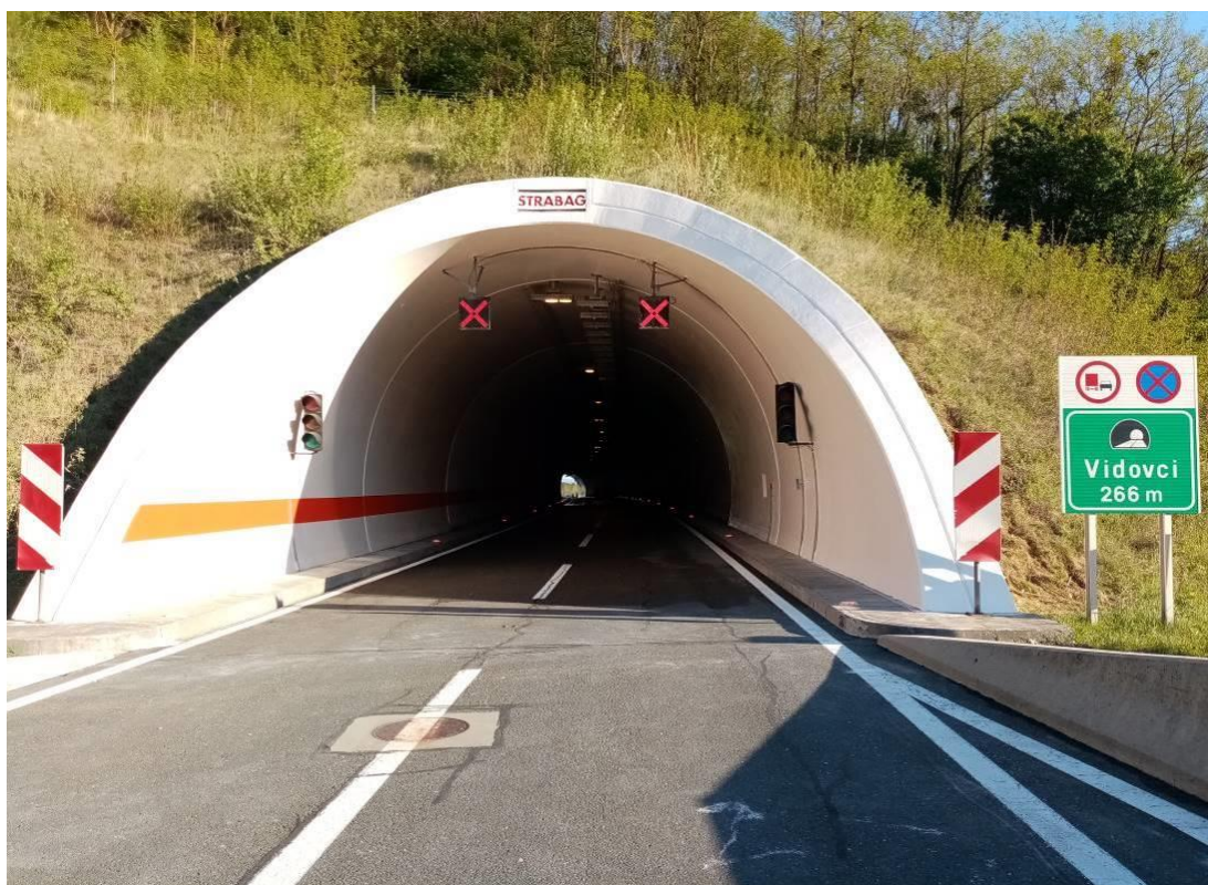
Slika 61. Izgled obloge nakon završenih sanacijskih radova
