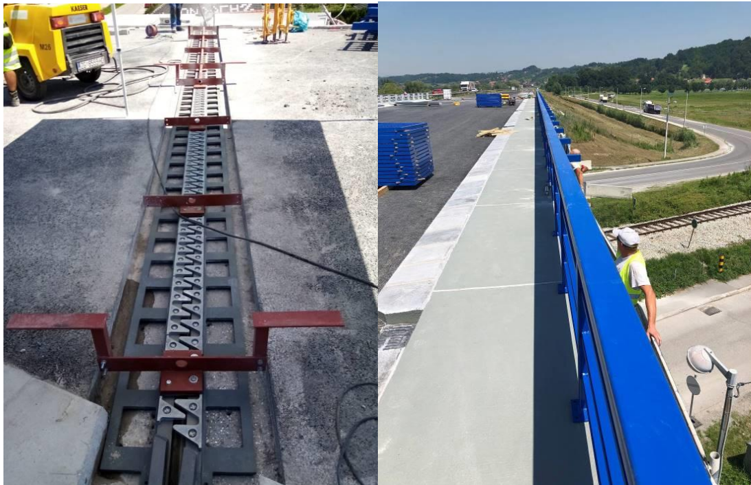
Slika 83. Ugradnja prijelaznih naprava, ograda i zaštitnog sustava betonskih površina
