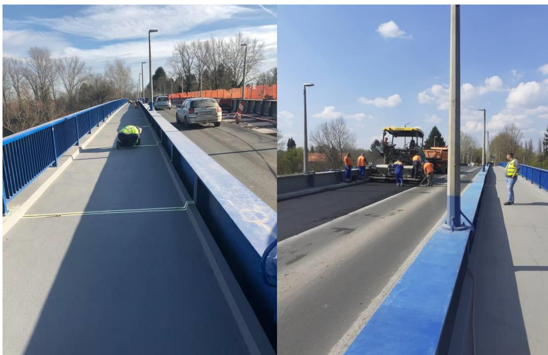
Slika 69. Ugradnja razdjelnica, završnog zaštitnog sustava i asfaltiranje mosta
