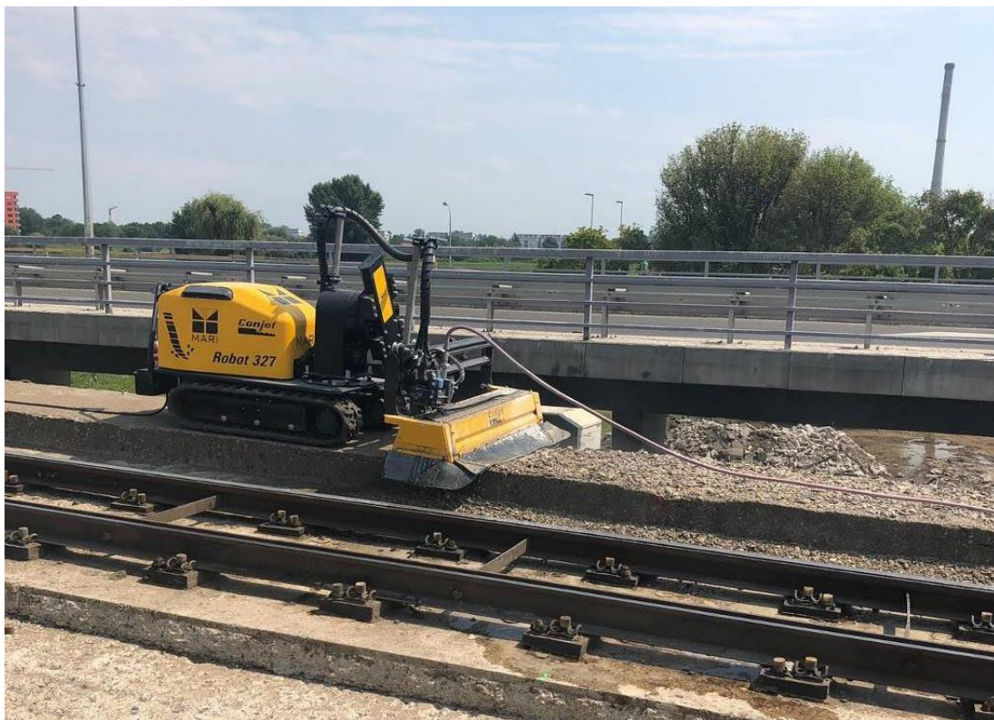
Slika 23. Hidrodemoliranje hodnika tramvajskog mosta Mladost robotiziranim uređajem
