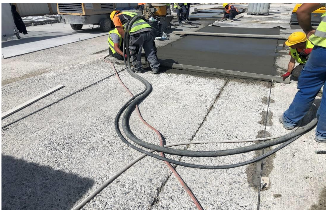
Slika 76. Reprofilacija kolničke ploče nakon uklanjanja oštećenog betona
