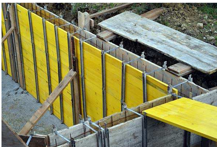
Slika 3.1.4. Postava oplata AB zidova
