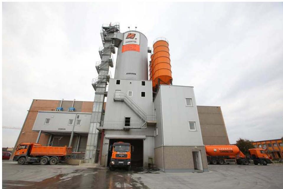
Slika 3.1.2. Tvornica betona poduzeća Zagorje-Tehnobeton d.d
