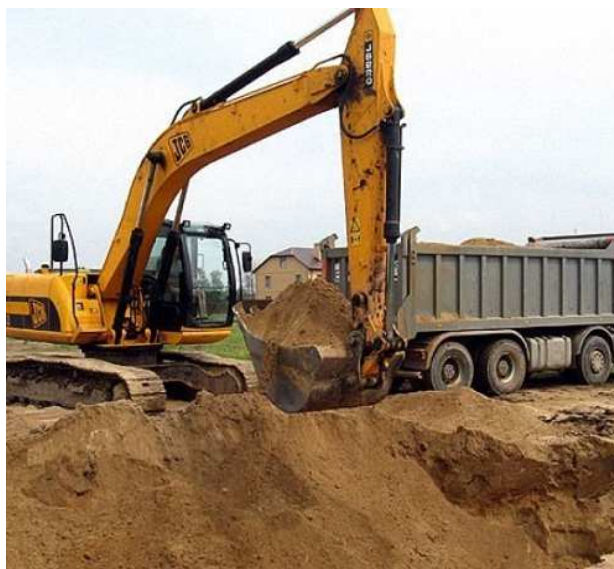
Slika 3.1.1. Strojni iskop zemljanog materijala
