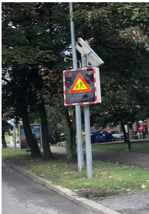
Slika 23. Promjenjiva prometna signalizacija opremljena senzorima
