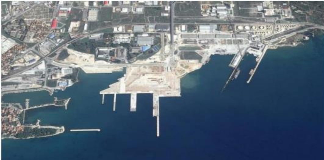
Slika 9 Luka Gaženica u vrijeme izgradnje 2014. godine
