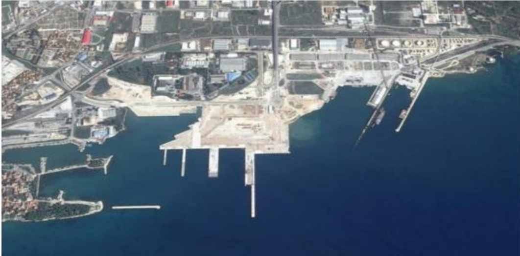
Slika 9 Luka Gaženica u vrijeme izgradnje 2014. godine
