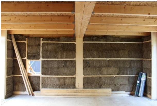
Slika 1.3. Blokovi bala u drvenoj konstrukciji Slika 1.4. Žbukanje slame
