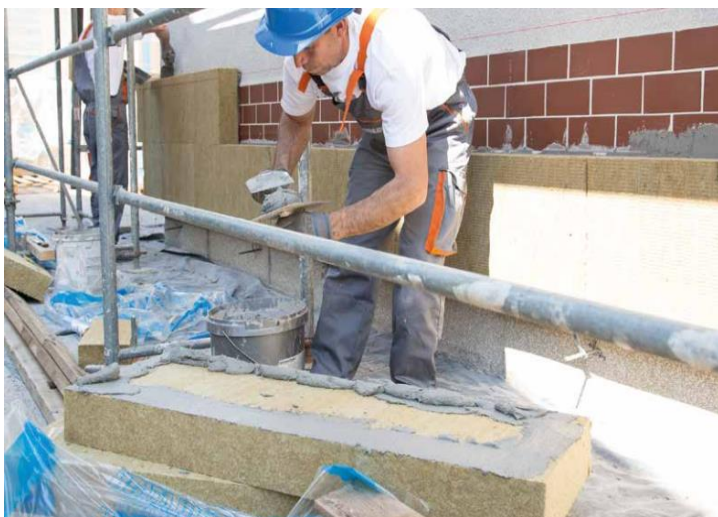
Slika 4.1.1. Izoliranje zida kamenom vunom
