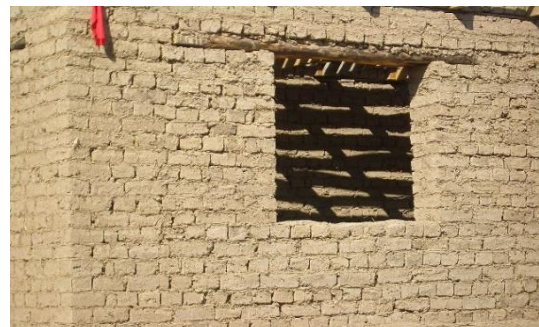
Slika 1.2. Ćerpič u izvedbi
