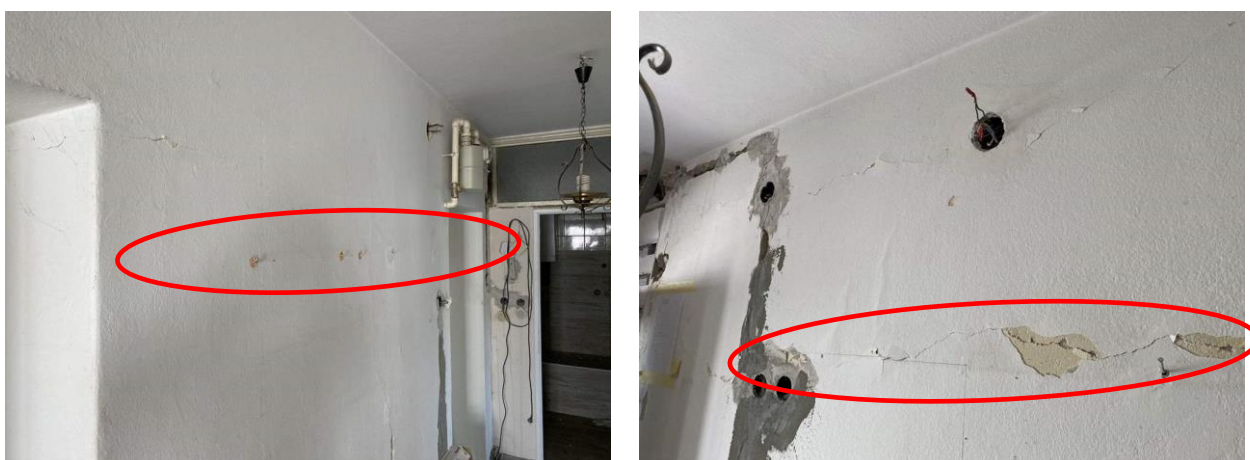
Slika 4.13. Unutrašnji zidovi prizemlja etaže 2;
