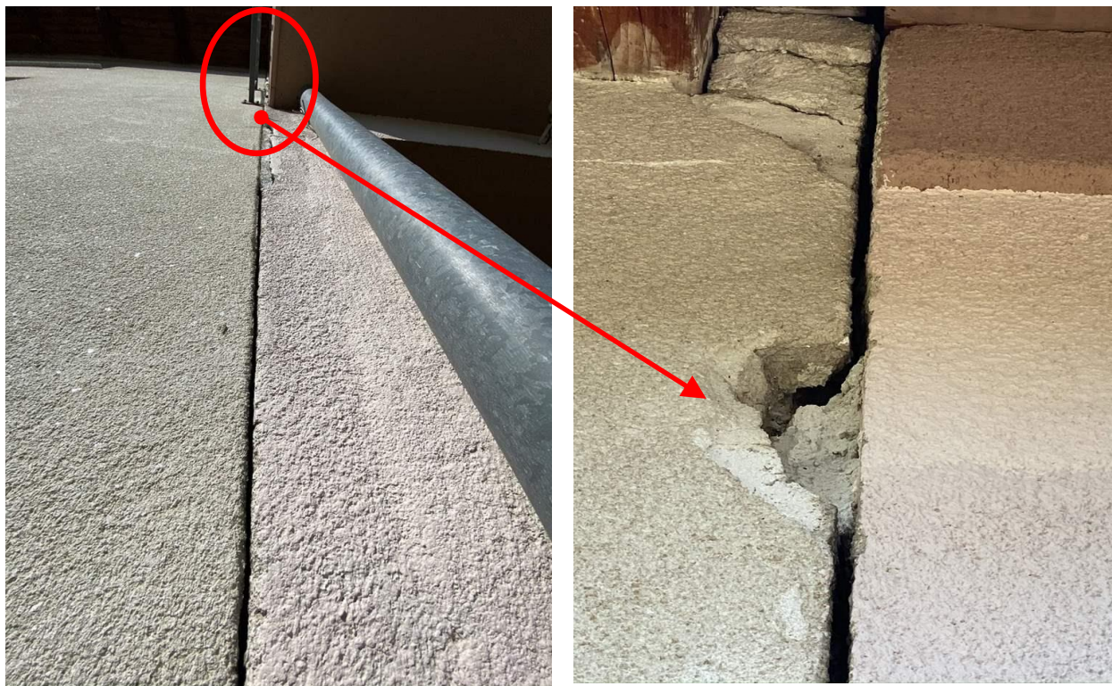
Slika 4.20. Zapadna dilatacija između dvije građevine; pogled na južno pročelje;
