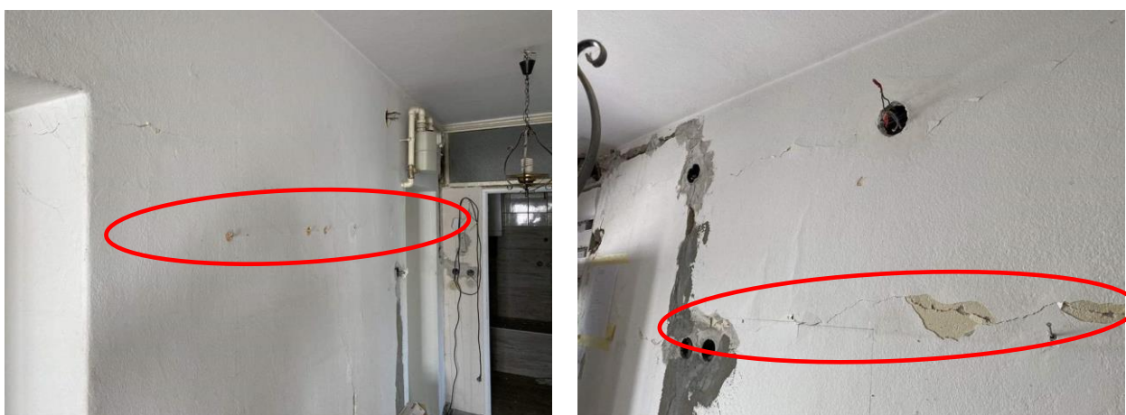
Slika 4.13. Unutrašnji zidovi prizemlja etaže 2;
