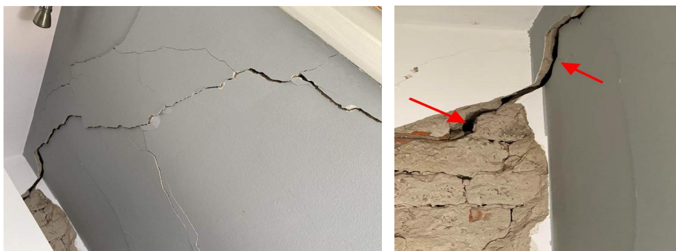
Slika 4.3. Jugoistočni kut zgrade; unutrašnjost;
