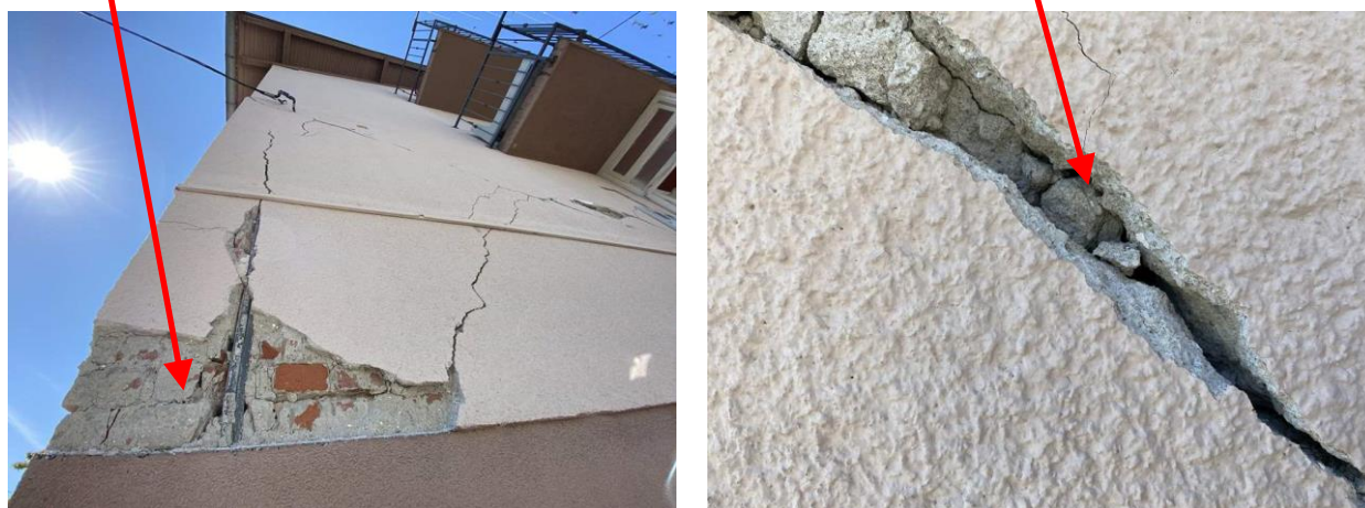
Slika 4.5. Istočni zid te jugoistočni kut zgrade; pogled izvana;
