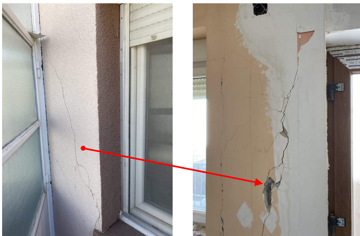
Slika 4.10. Ulaz u prizemlje (etaža 2), istočna strana;
