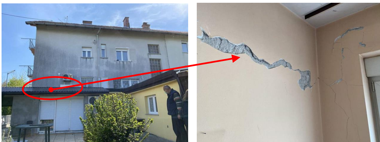
Slika 4.8. Nosivi zid na sjevernom zidu, SI kut (lijevo), pogled iz unutrašnjosti (desno);
