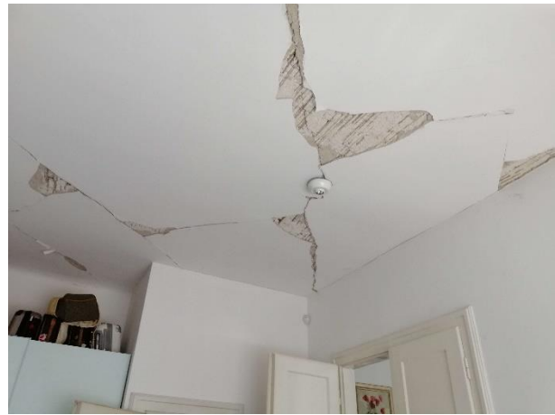
Slika 4.16. Spavaća soba također ispunjena stropnim unakrsnim pukotinama
