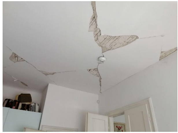
Slika 4.16. Spavaća soba također ispunjena stropnim unakrsnim pukotinama
