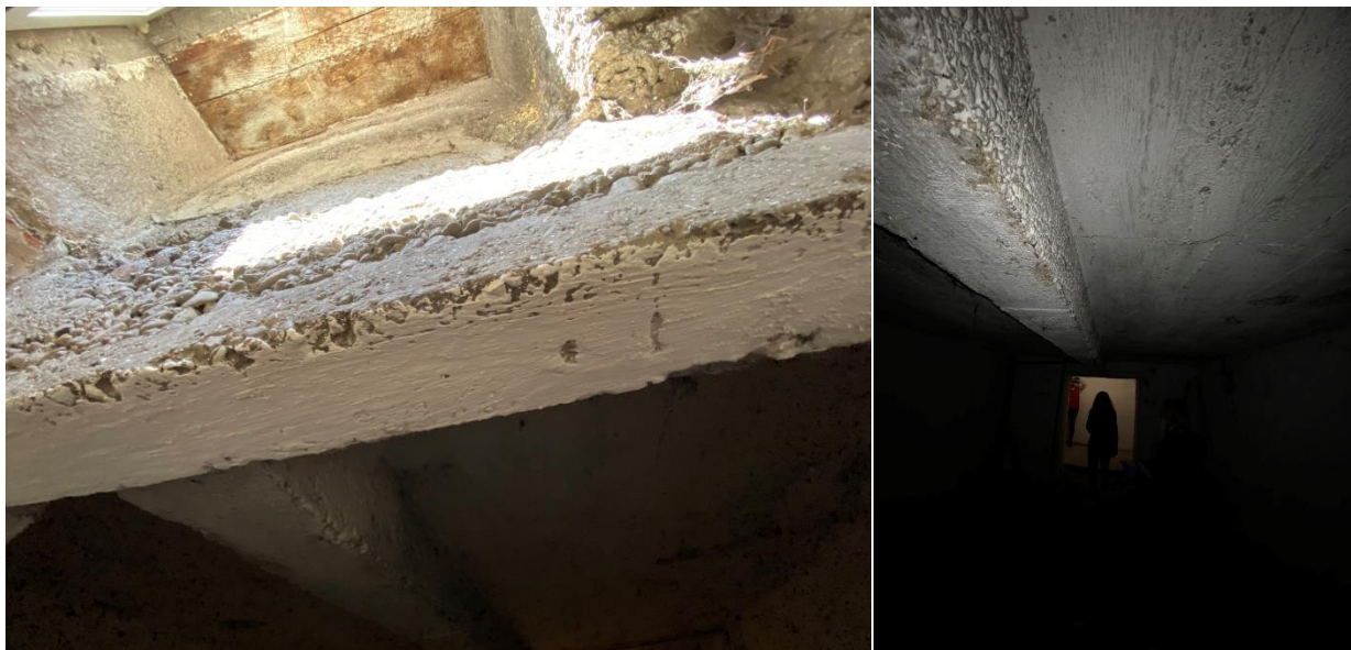
Slika 4.43. Nosivi sustav ploče prizemlja
