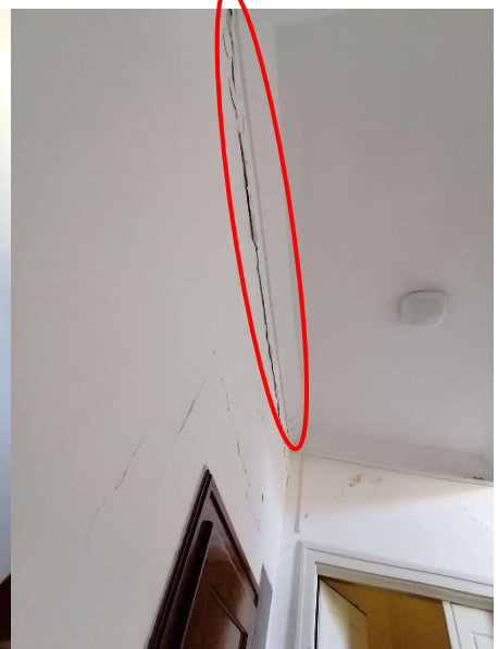
Slika 4.39. Već karakteristične horizontalne pukotine na spojevima zidova i stropova
