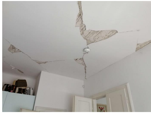
Slika 4.16. Spavaća soba također ispunjena stropnim unakrsnim pukotinama
