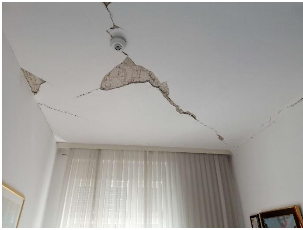
Slika 4.16. Spavaća soba također ispunjena stropnim unakrsnim pukotinama
