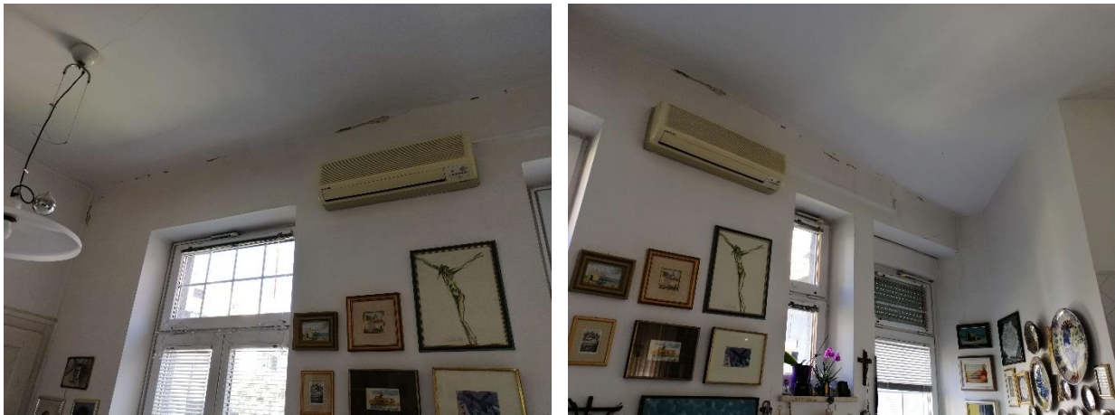
Slika 4.19. Horizontalne pukotine uzduž vanjskog nosivog zida
