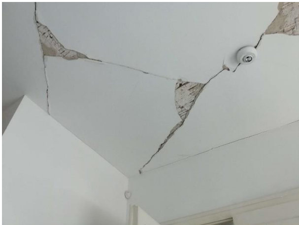
Slika 4.17. Razvoj stropnih pukotina od kutova sobe prema sredini
