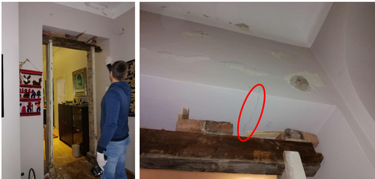
Slika 4.3. Oštećenje nadvoja
