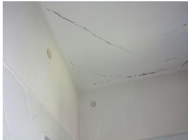
Slika 4.17. Razvoj stropnih pukotina od kutova sobe prema sredini
