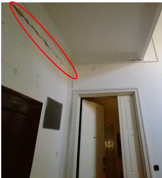
Slika 4.39. Već karakteristične horizontalne pukotine na spojevima zidova i stropova
