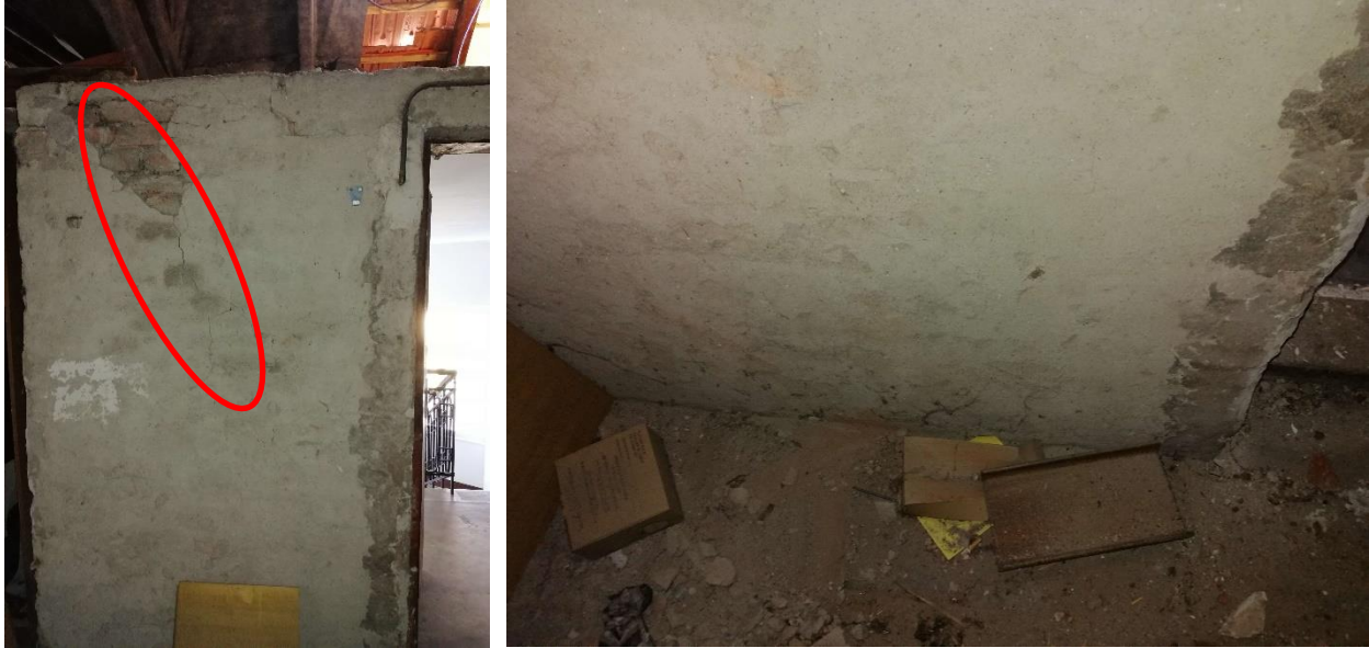
Slika 4.27. Pregradni zid sa tavanskim stanom sa druge strane zida
