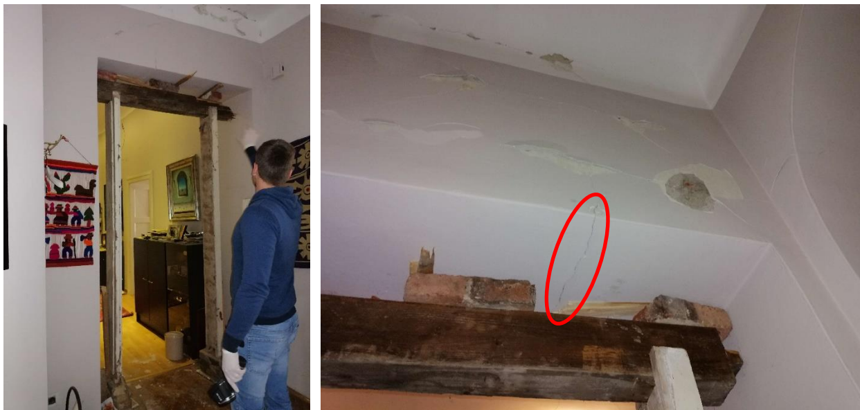
Slika 4.3. Oštećenje nadvoja
