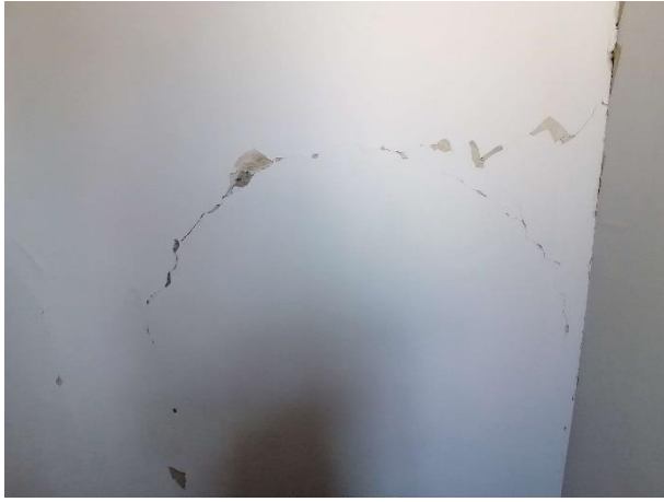
Slika 4.38. Duboke zidne pukotine na mjestima nekadašnjih otvora (lučni otvori se iscrtavaju pukotinskim oštećenjem)
