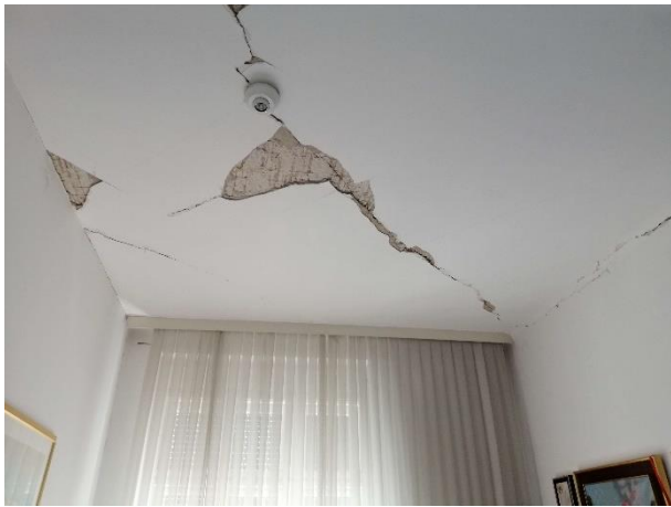
Slika 4.16. Spavaća soba također ispunjena stropnim unakrsnim pukotinama
