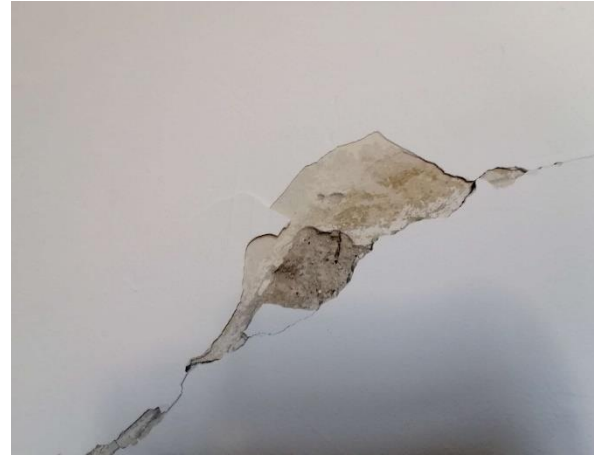
Slika 4.38. Duboke zidne pukotine na mjestima nekadašnjih otvora (lučni otvori se iscrtavaju pukotinskim oštećenjem)
