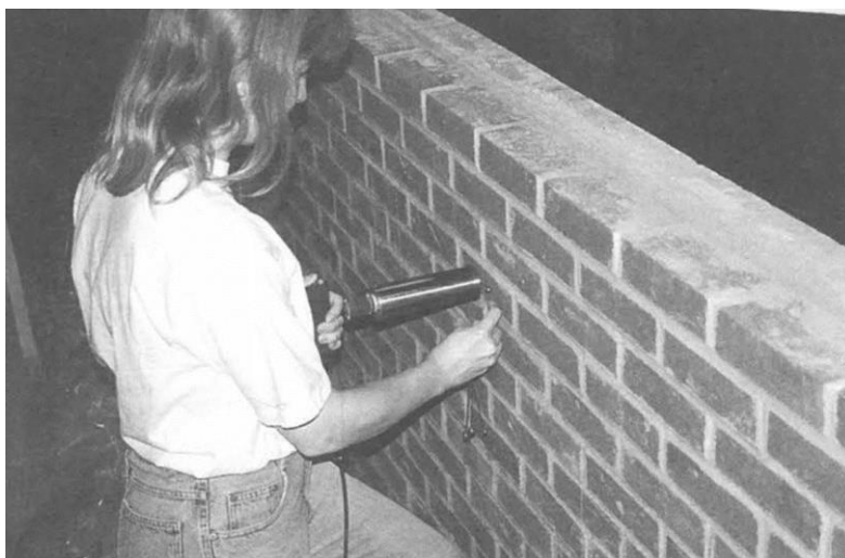
Slika br. 3.29. Zidani zid koji se sastoji od vanjskog dijela opeke i unutarnjeg dijela betonskog bloka [7]
