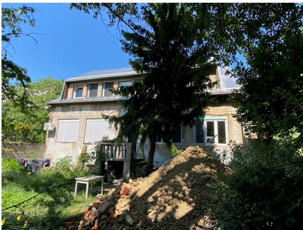
Slika 3.11. Pogled na zapadno pročelje predmetne zgrade
