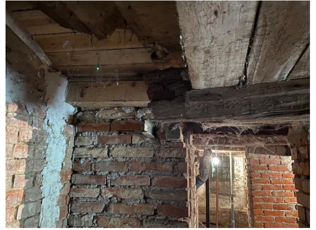
Slika 3.14. Prikaz stropne konstrukcije u podrumu
