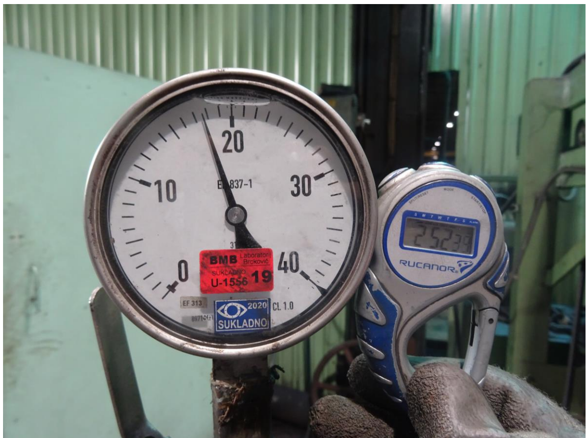
Slika 25. Ispitivanje nepropusnosti dosjeda, potreban pritisak i trajanje ispitivanja
