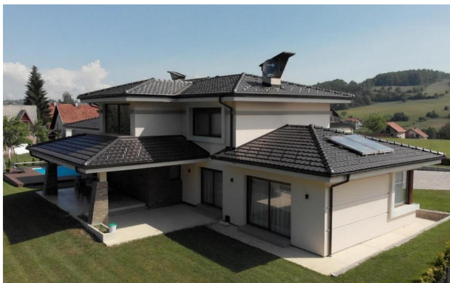
Slika 3.14 Pokrov od glinenog utorenog crijepa
