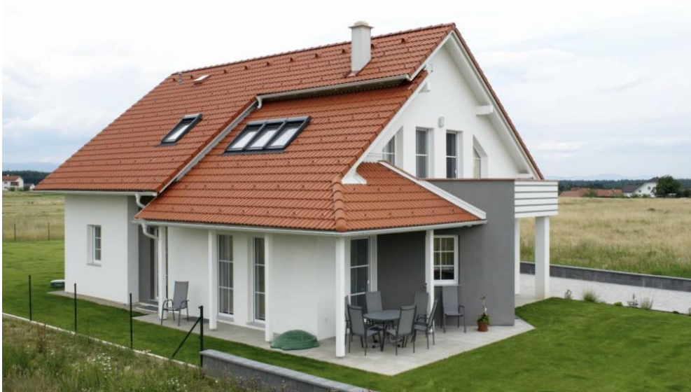
Slika 3.16 Pokrov od betonskog utorenog crijepa
