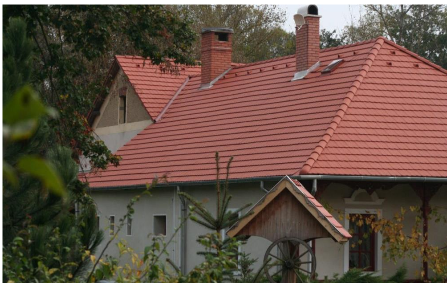
Slika 3.15 Pokrov od betonskog biber crijepa
