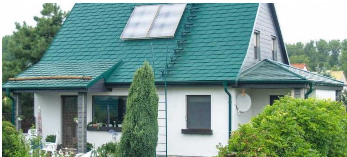
Slika 3.31 Pokrov od metalne šindre
