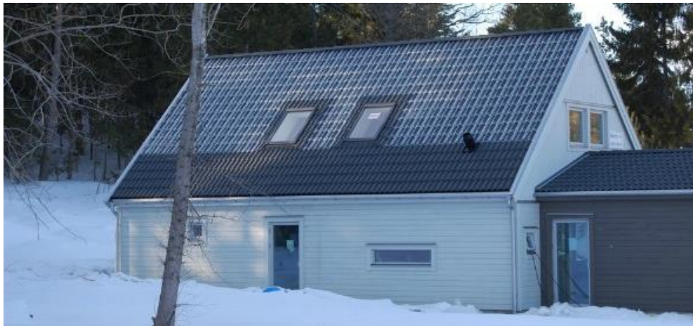
Slika 3.35 Pokrov od staklenog crijepa
