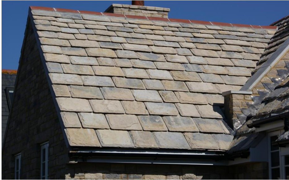
Slika 3.8 Pokrov od kamenih ploča
