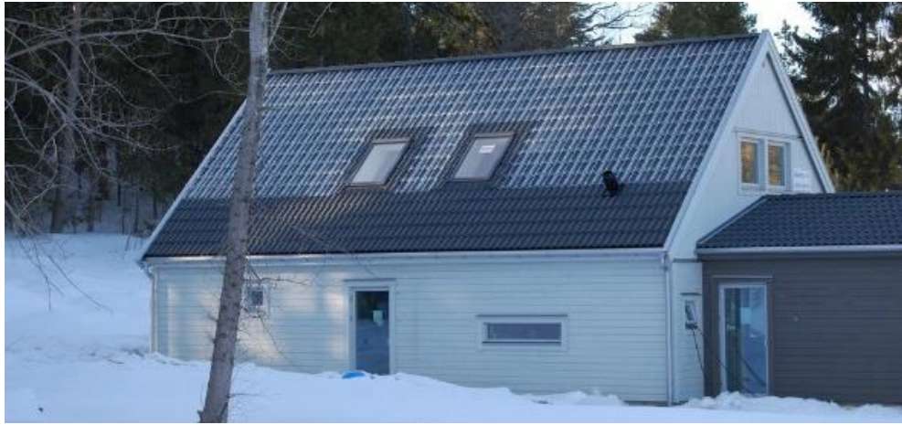
Slika 3.35 Pokrov od staklenog crijepa
