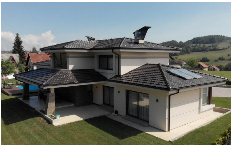
Slika 3.14 Pokrov od glinenog utorenog crijepa
