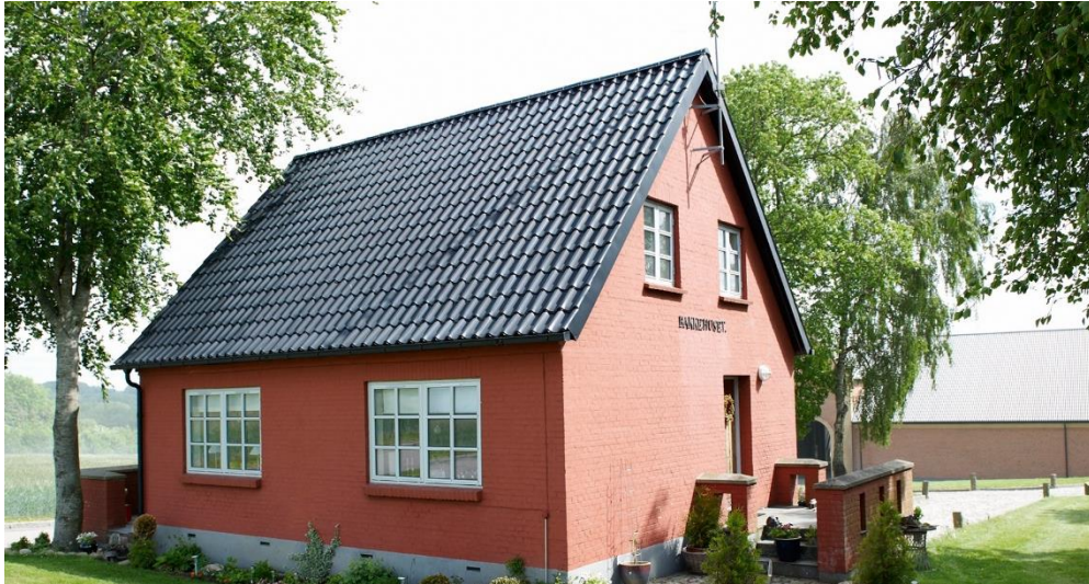
Slika 3.29 Pokrov od specijalnih metalnih ploča
