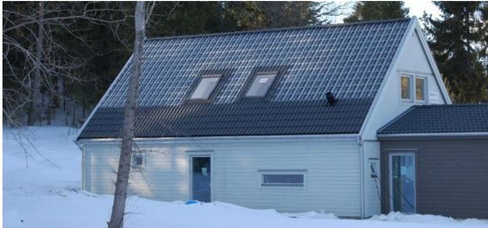
Slika 3.35 Pokrov od staklenog crijepa
