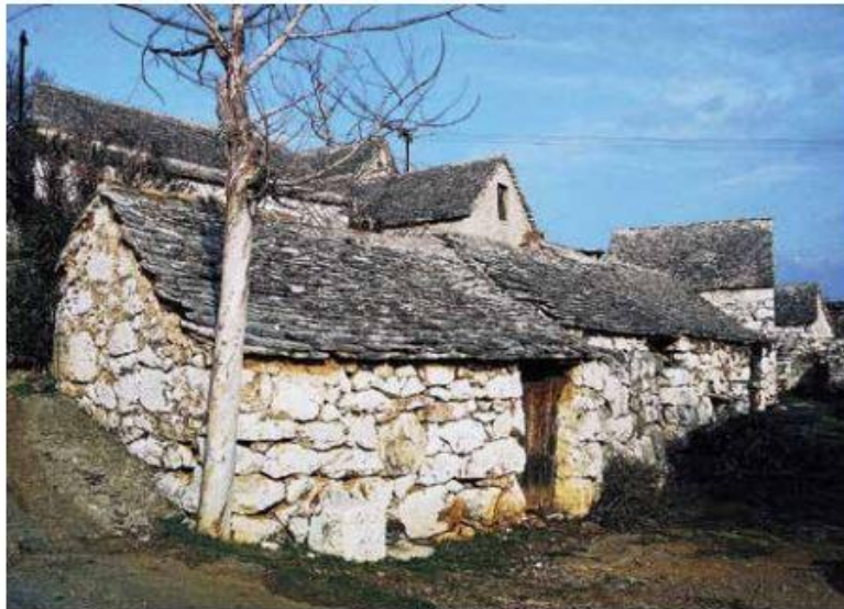
Slika 2.4 Povijesni pokrov od kamenih ploča
