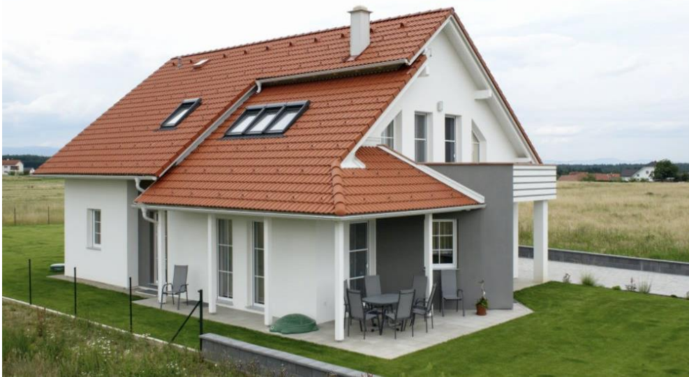
Slika 3.16 Pokrov od betonskog utorenog crijepa
