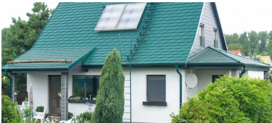
Slika 3.31 Pokrov od metalne šindre
