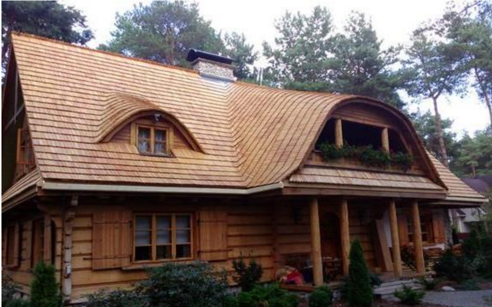
Slika 3.6 Pokrov od drvene šindre
