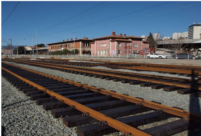
Slika 41. Željeznički kolosijek na drvenim pragovima
