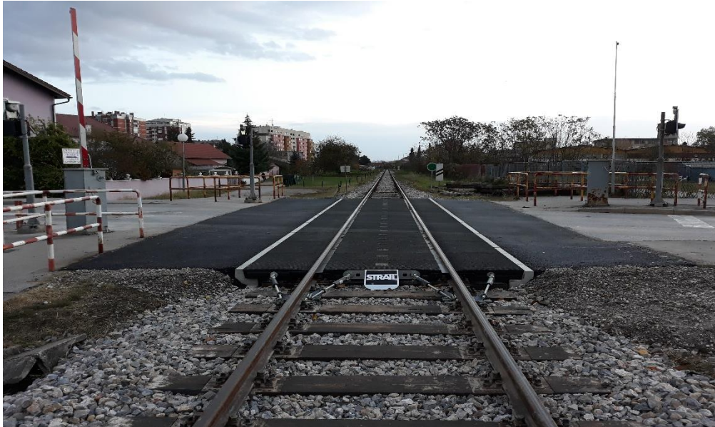
Slika 48. Sintetičko popođenje STRAIL
