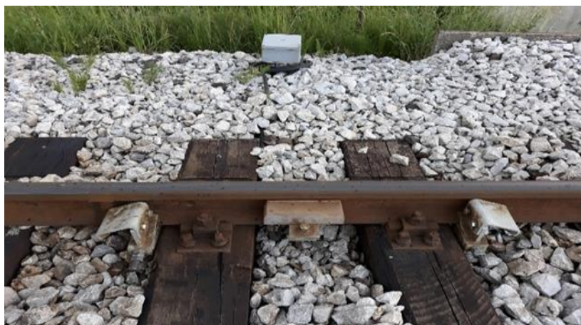
Slika 54. Tračničko uključno-isključni elementi T-U/I
