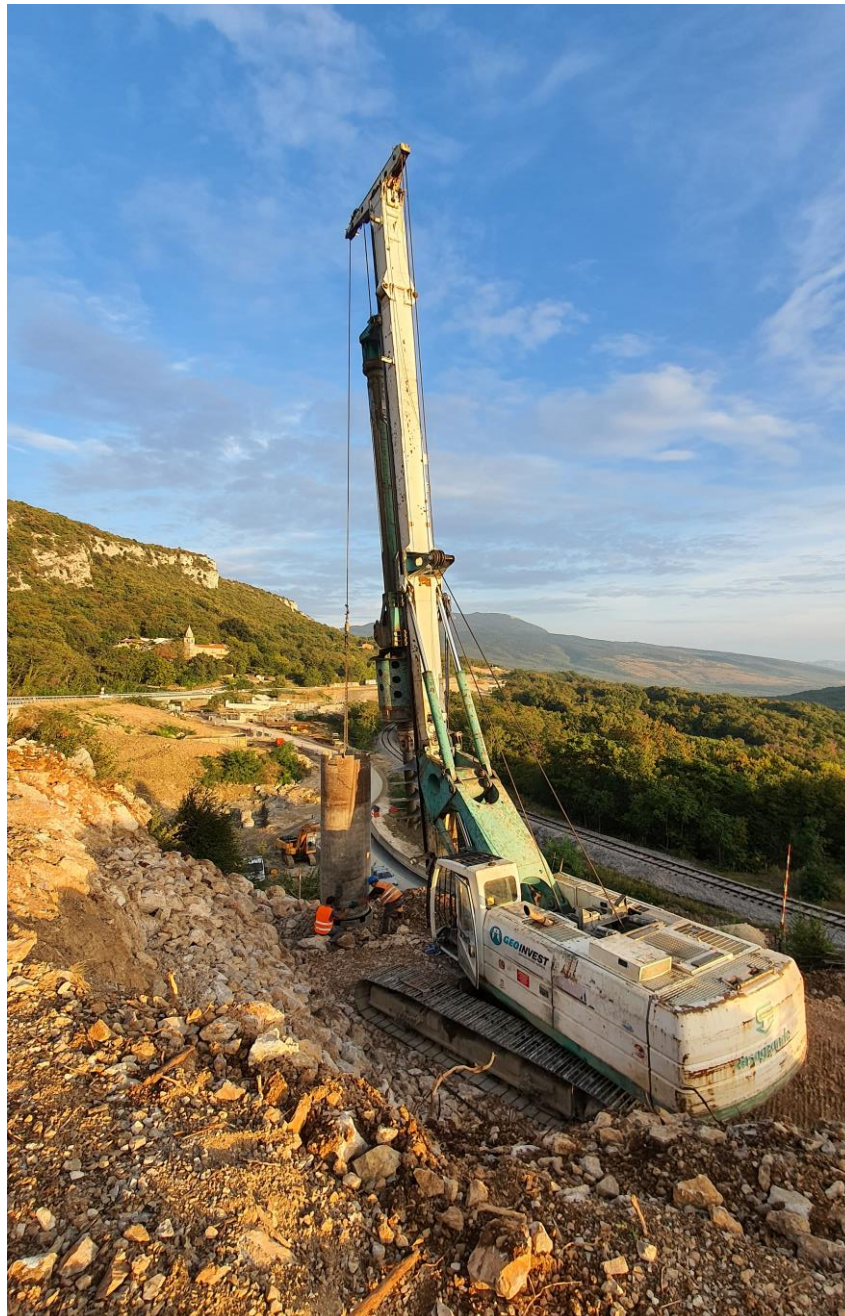
Slika 4.1.1-1 Bušaći stroj Casagrande B180
