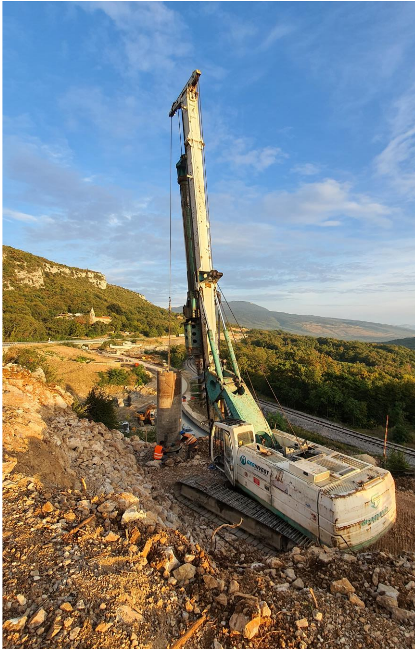
Slika 4.1.1-1 Bušaći stroj Casagrande B180
