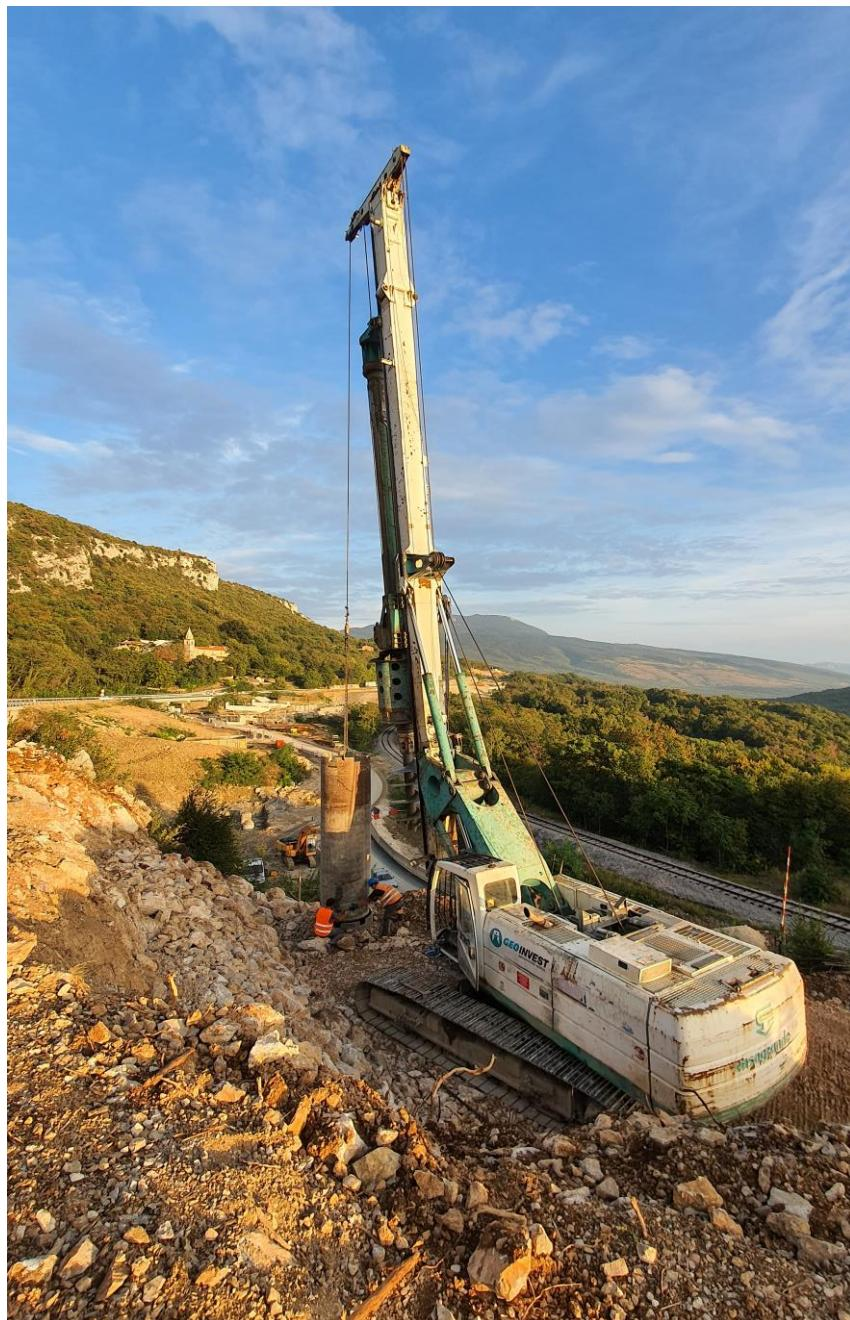
Slika 4.1.1-1 Bušeći stroj Casagrande B180
