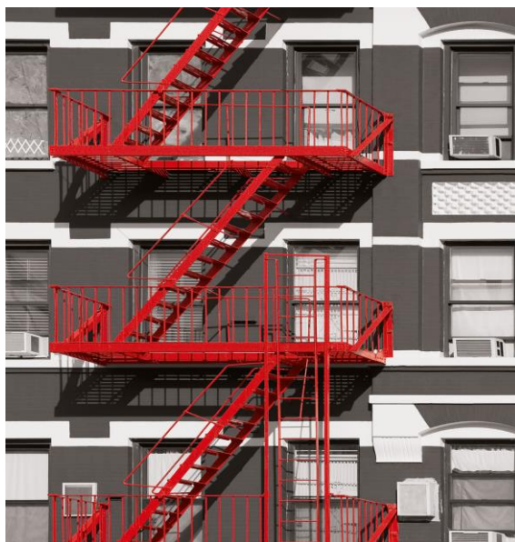
Slika 5.1 Protupožarne stube za sigurno spašavanje osoba ili spašavatelja
