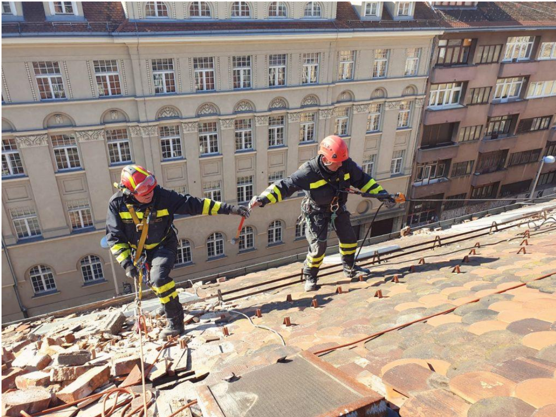
Slika 2.1 Tehnička intervencija - sanacija dimnjaka nakon razornog potresa u Zagrebu
