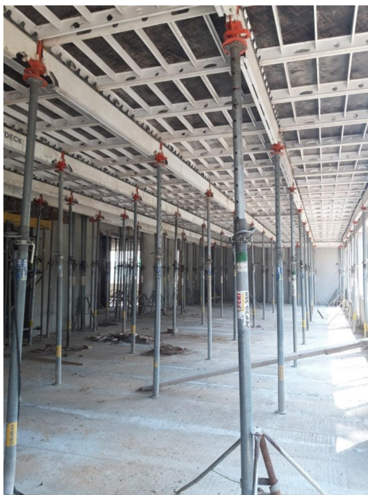
Slika 8: Prikaz postavljene oplata i podupirača
