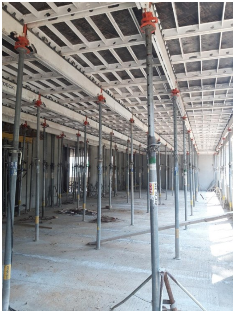
Slika 8: Prikaz postavljene oplata i podupirača
