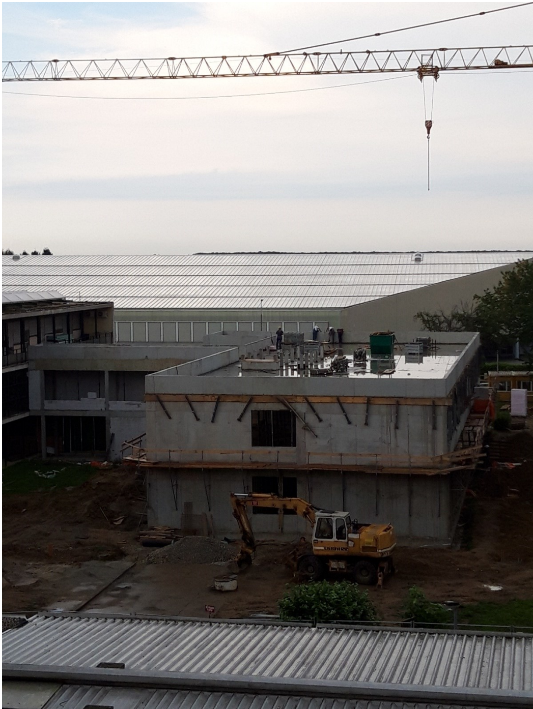
Slika 7: Završeni armirači i betonski radovi na objektu
