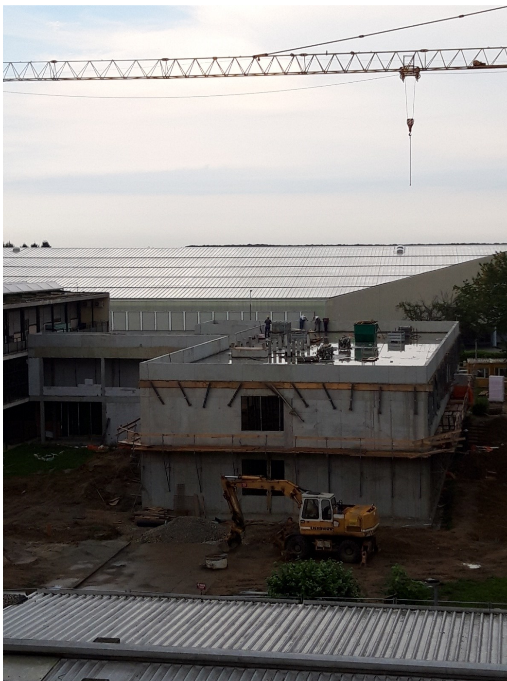
Slika 7: Završeni armirači i betonski radovi na objektu
