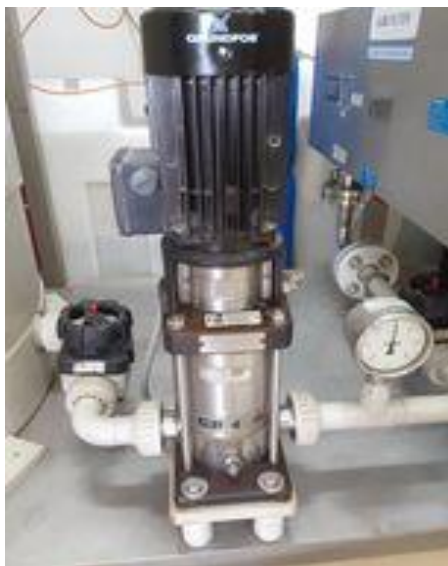
Slika 3.4. Cirkulacijska pumpa (vlastiti izvor)
