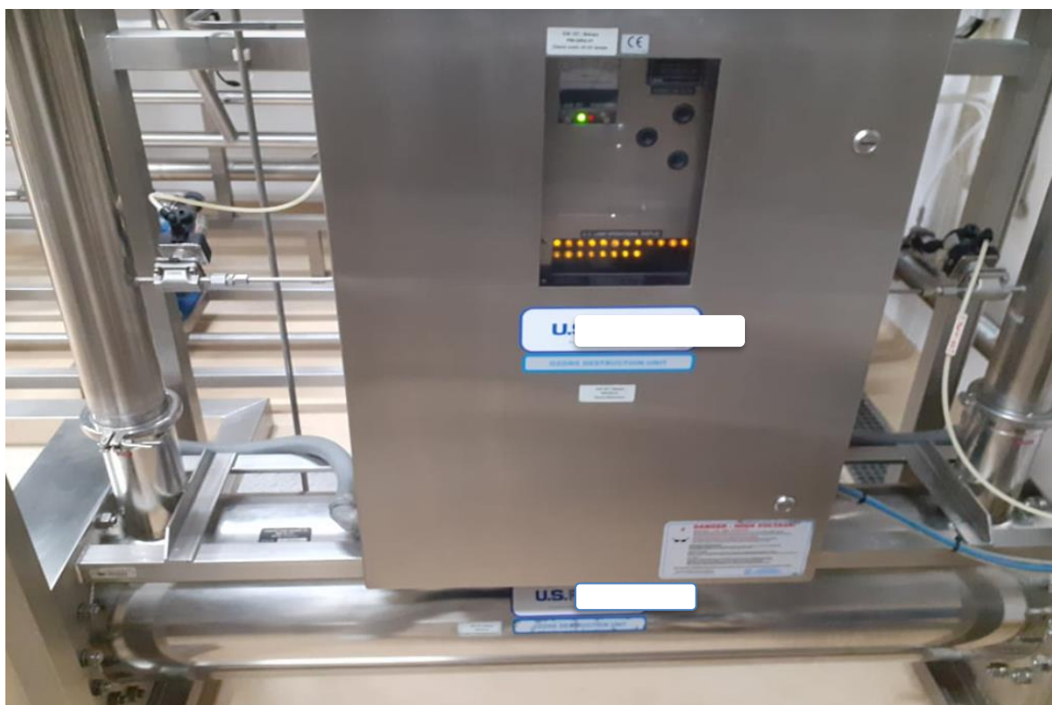
Slika 3.20. Regulator intenziteta i kućište s 20 UV lampi (vlastiti izvor)
