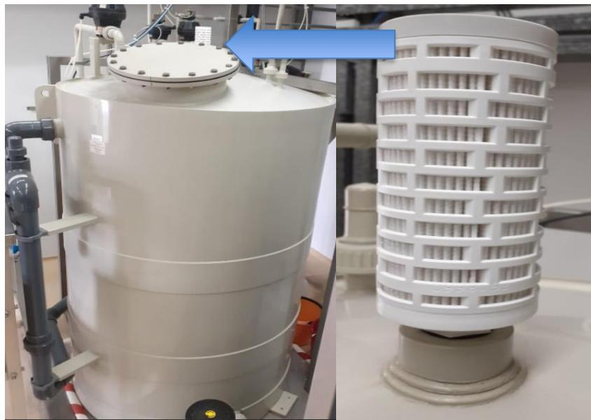
Slika 3.3. Spremnik gradske vode s odzračnim filterom poroznosti  $0,01 \mu\text{m}$  (vlastiti izvor)
