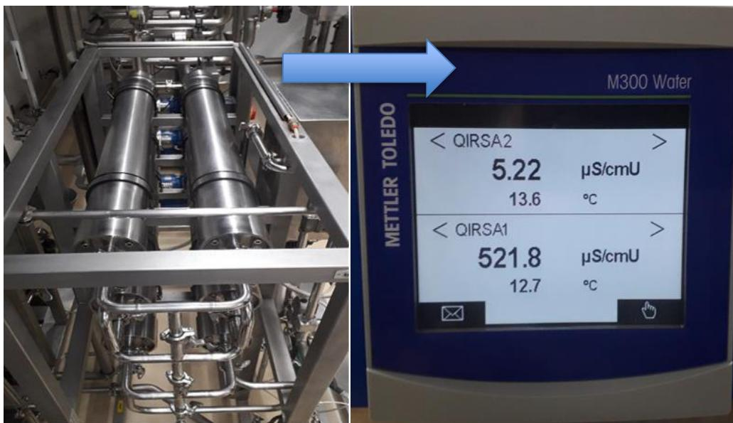
Slika 3.15. Kućište membrana RO i vrijednosti ulaza i izlaza vode na RO (vlastiti izvor)
