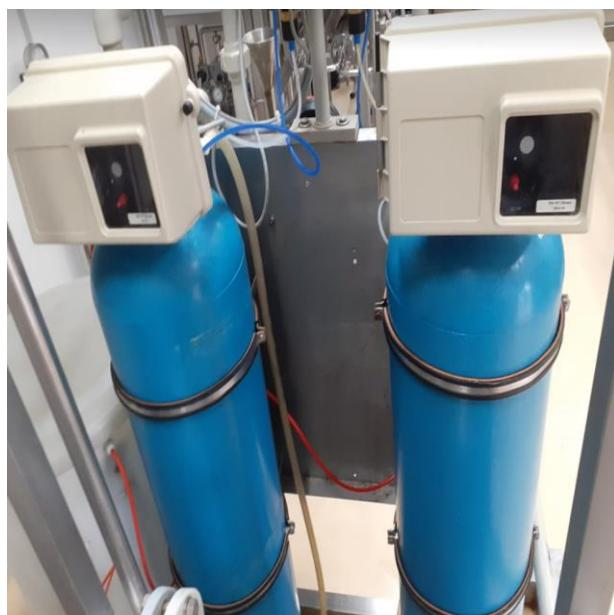
*Slika 3.7. Ionski izmjenjivači (vlastiti izvor)*
