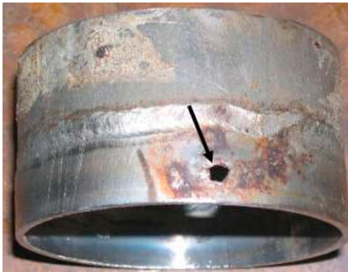
Slika 2 - Točkom je označena lokalna korozija na metalnom elementu
