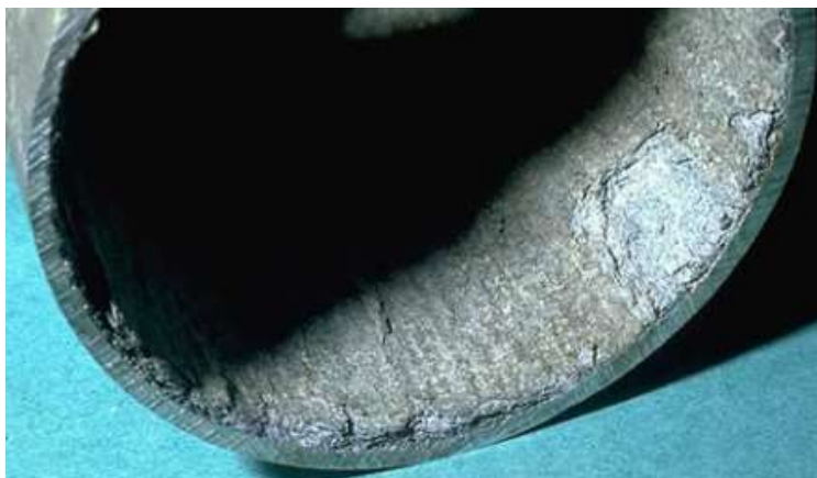
Slika 4 - Primjer selektivne korozije
