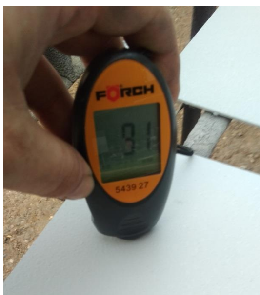
Slika 37: Mjerenje debljine suhog sloja temeljnog premaza
