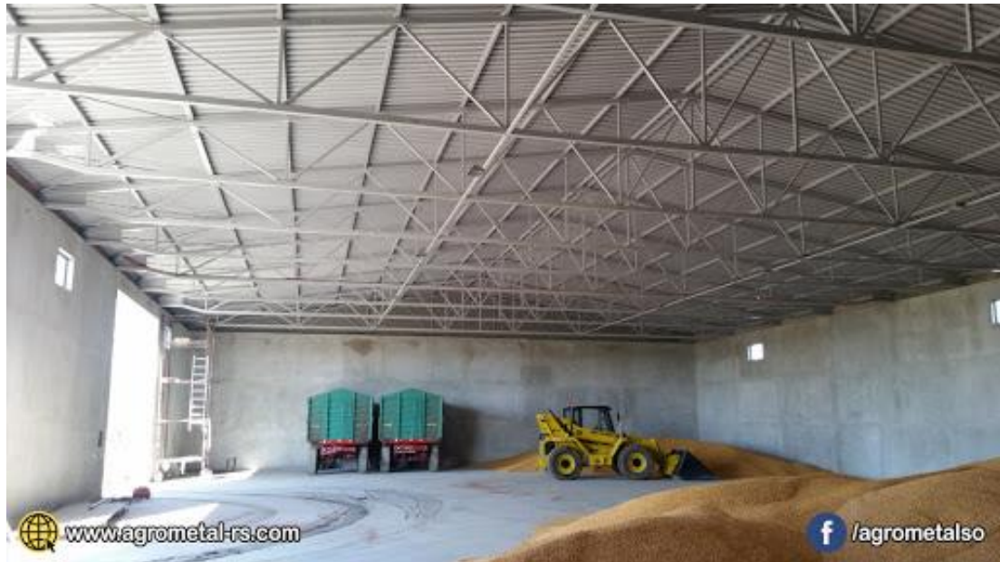
Slika 1. Podno skladište za rasute terete
